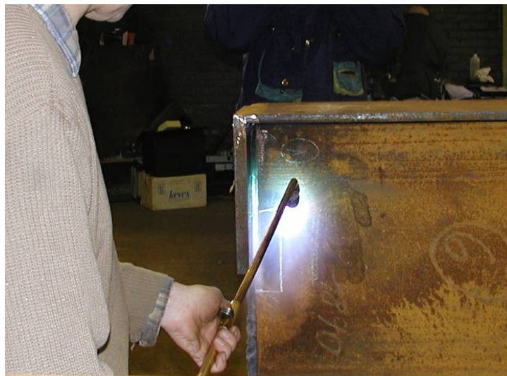
Figura 2.16. Fotografía de un operario aplicando alivio térmico a un perfil doble T con semi-placa soldada (fotografía proporcionada por Arcelor-Mittal [60]).
