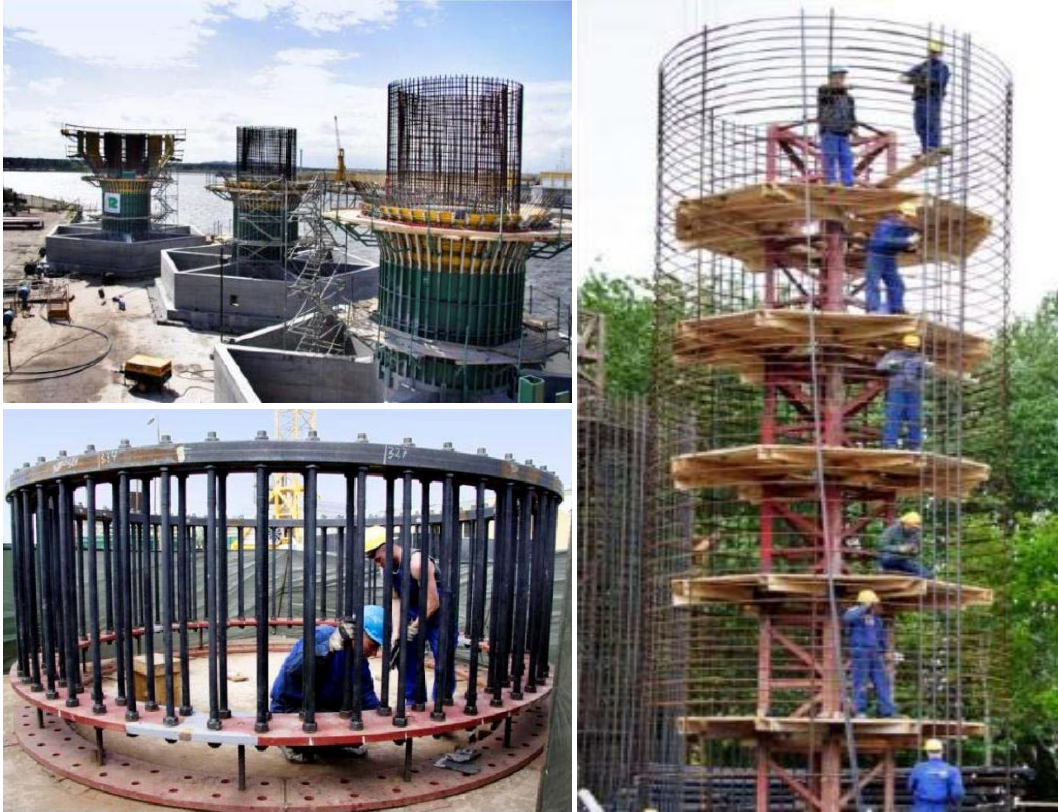
Foundation manufacture (Vattenfall)
