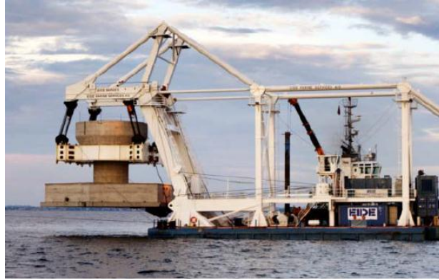
Foundation installation (Vattenfall)
