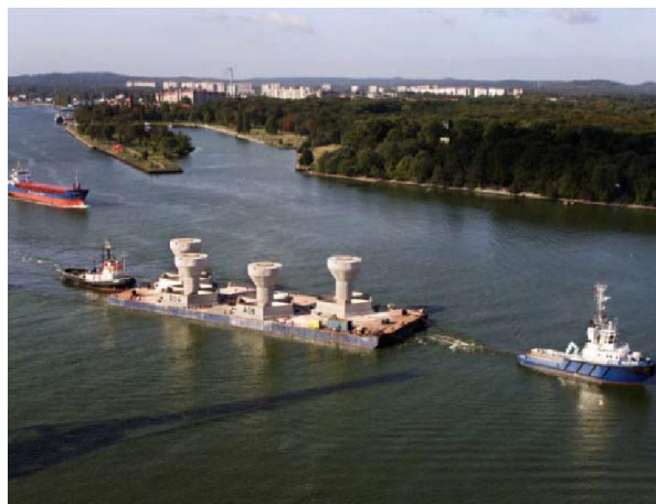
Foundations transport (Vattenfall)
