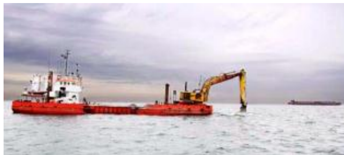
Seabed preparation (Vattenfall)
