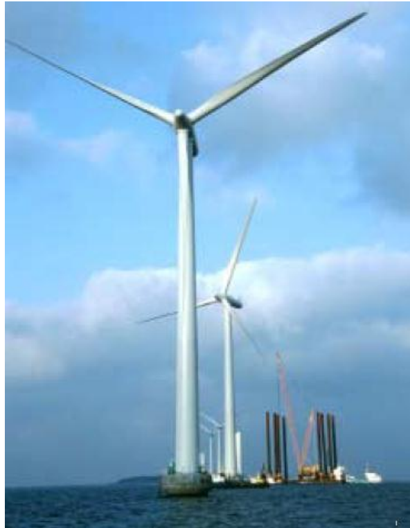
Turbine installation (Middelgrunden)
