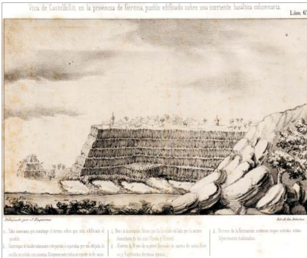
FIG. 6. «Vista de Castellfollit», EZQUERRA (1850-55).
