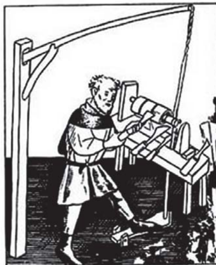
Figura 1-6: Torno de polea. Mendelsches Bruderbuch 1395 (Derry 1993).
