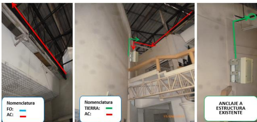
Figura 20: Fotomontaje recorrido cable de energía (continuación) y puesta a tierra
