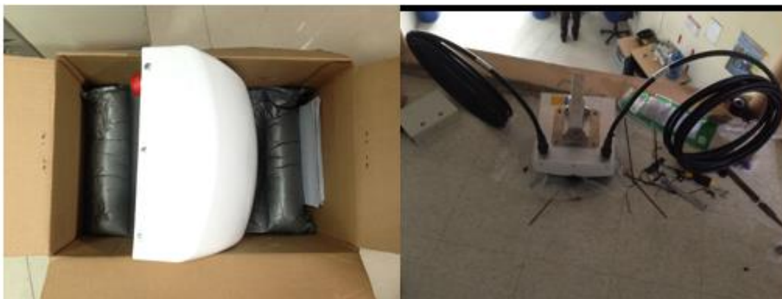
Figura 23: Preparación de antena para instalación
