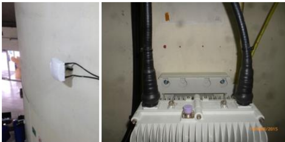
Figura 33: Montaje de la antena
