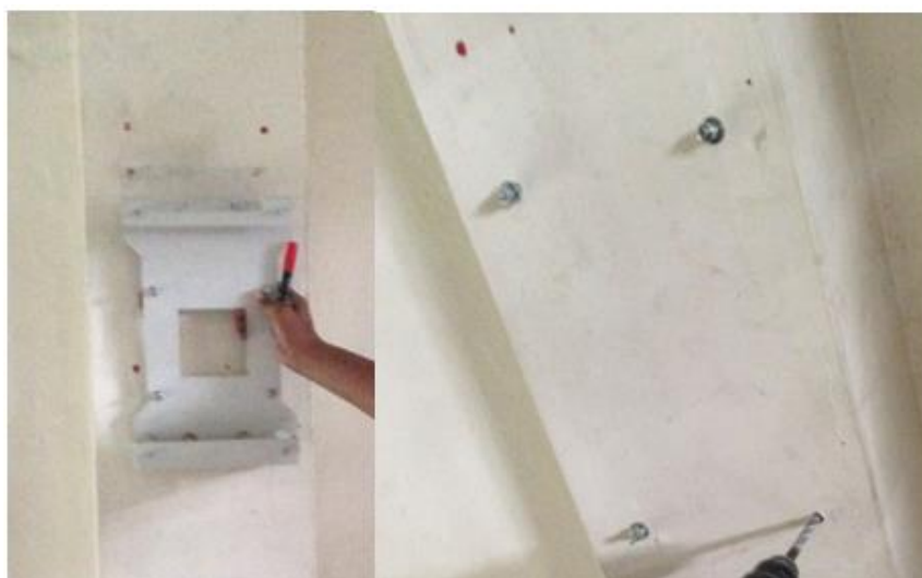
Figura 24: Montaje de soporte para Small Cell
