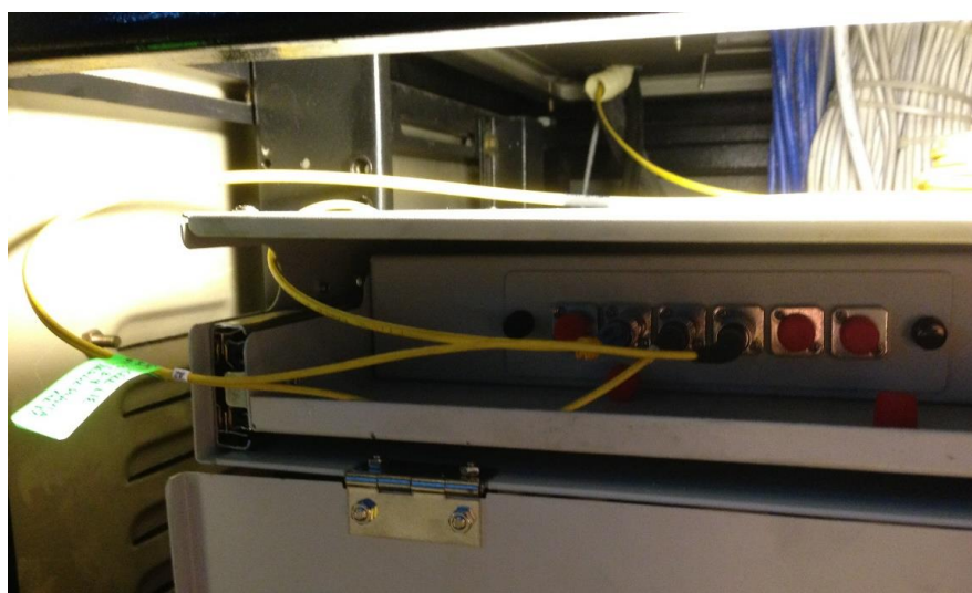
Figura 39: Conexión de fibra al ODF del operador
