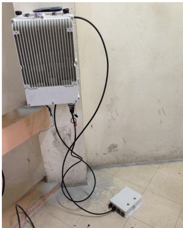
Figura 32: PDU conectado a la Small Cell
