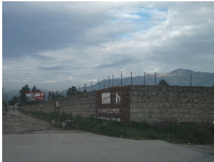
FOTOGRAFÍA N° 5 CONJUNTO "VILLA ALMENDRO"
