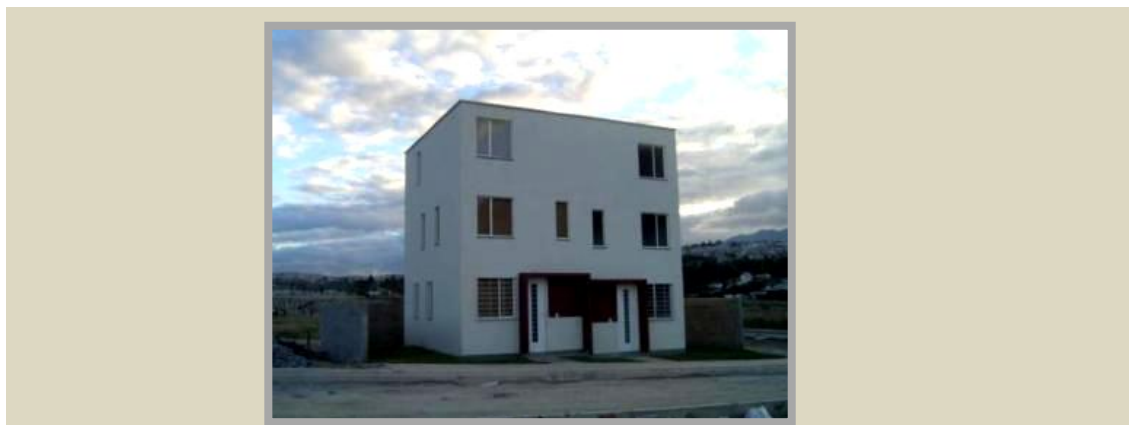
Foto 4-3. Ecuacanelos. Proceso constructivo: Casa terminada
