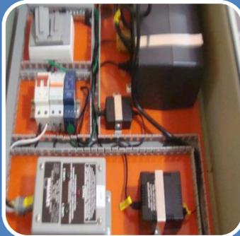
Una vez concluido las conexiones que se hace en las cajas eléctricas antes del montaje en el poste donde se encuentra la cámara de video vigilancia, se procede a ubicar en la canaleta los cables usados de manera ordenada para cerrarla ..
