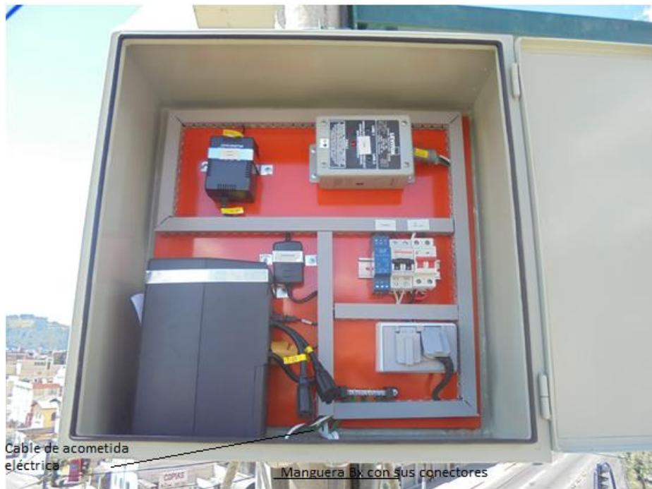
**Figura 21 Ingreso a Caja Eléctrica de Acometida por medio de manguera Bx de  $\frac{3}{4}$ .**
