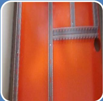
Primero se procede a colocar la canaleta dentro del tablero eléctrico, fijándola con tornillos para proceder a instalar el resto de elementos.
