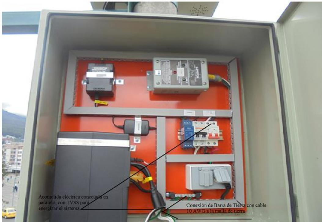
**Figura 22 Energización del Sistema de alimentación y protección.**
