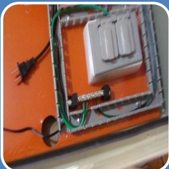
Conexión de las tierras del TVSS, del tomacorrientes, de la protección adicional de la cámara a la barra de tierra.
