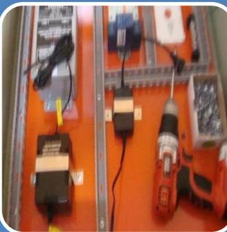
Se instalan los transformadores que sirven para la alimentación eléctrica de la cámara de video vigilancia y para el conversor de medios. y se los sujeta en el tablero con la ayuda de las laminas de acero inoxidable.
