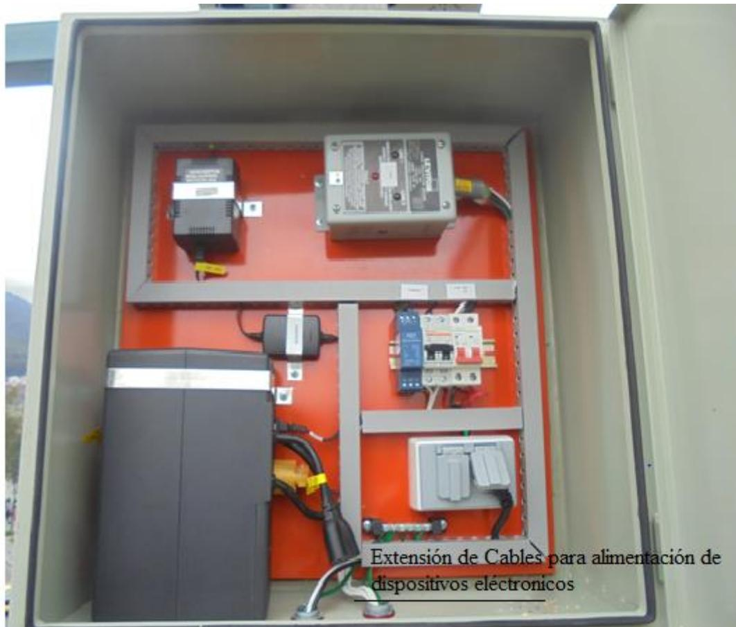
**Figura 23 Extensión de cables para Alimentación Eléctrica de Dispositivos Electrónicos.**
