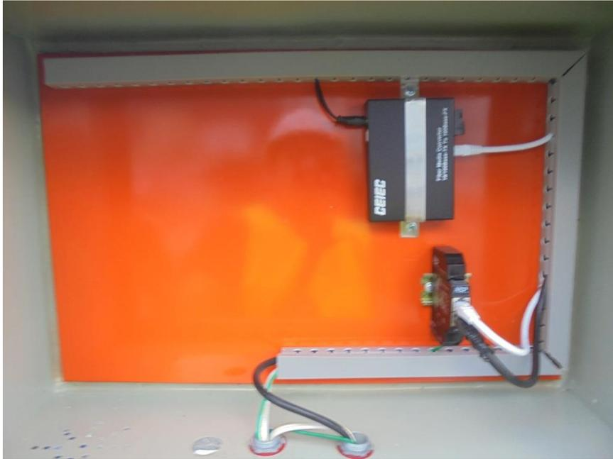
**Figura 25 Alimentación eléctrica conversor de Ethernet a Fibra**
