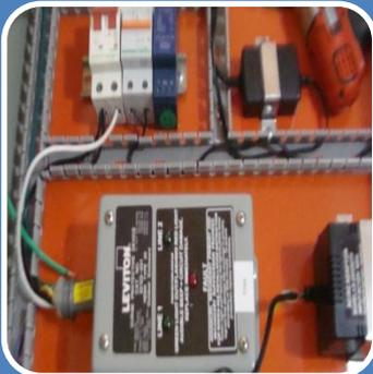
Ahora se conecta los cables blanco y negro del TVSS, a la entrada del breaker de 20A, lugar al que llega la acometida eléctrica de 110V AC, la salida del transformador de 24 V AC se lo coloca en la entrada del breaker de 6A.
