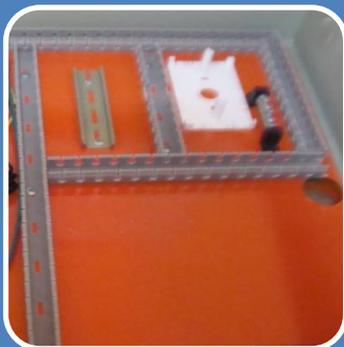
Luego se fija la barra de tierra, base del tomacorrientes y la barra para las protecciones del tablero.
