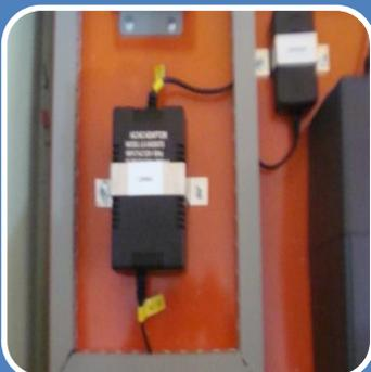
Para finalizar el proceso se etiqueta los diferentes elementos que se hallan en el tablero eléctrico, y brindar facilidad al momento de tener que dar mantenimiento a la misma.
