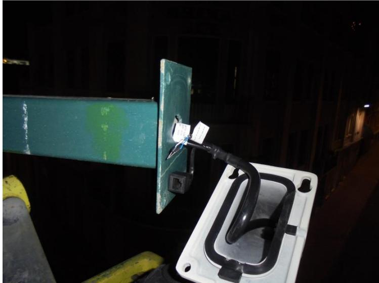
**Figura 24 Punto de Alimentación Eléctrica para funcionamiento de Cámara.**
