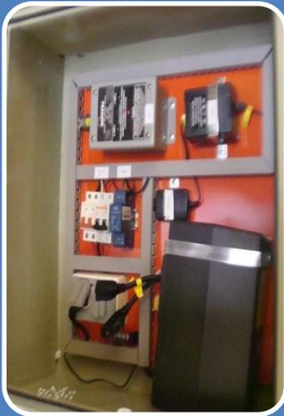
Tablero eléctrico terminado , que se encarga de la alimentación y protección eléctrica del sistema de cámaras de video vigilancia.
