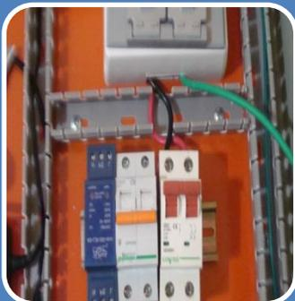
Conexión del tomacorrientes con la salida del breaker de 20 A que sirve como protección del sistema de alimentación eléctrica de las camaras de video vigilancia.
