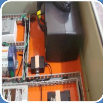
Instalación y fijación del UPS, el cual su alimentación eléctrica se lo hace de manera directa desde el tomacorrientes, para que se recarge las baterías internas de este dispositivo y pueda brindar autonomía al sistema en caso de falla del suministro eléctrico .
