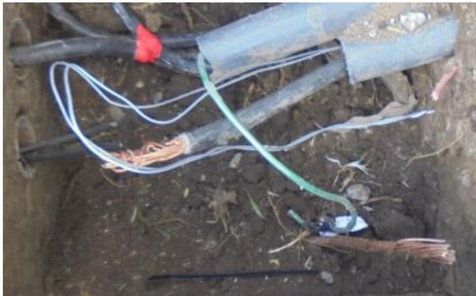
**Figura 5. Malla de Tierra del sistema de alimentación eléctrica.**
