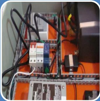
Se conecta a las tomas eléctricas de 110 V AC del UPS, a la entrada de los transformadores encargados de la alimentación eléctrica de los dispositivos electrónicos del sistema de cámaras de video vigilancia.
