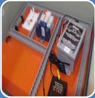
Se coloca en la posición que irá el TVSS, el transformador, y se instala en la barra las protecciones de 20A, y 6 A y las protecciones de la cámara.
