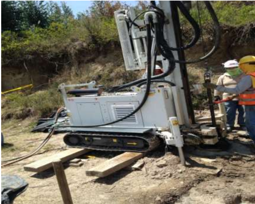
Figura 29, Maquina de perforaciones y ensayo SPT
