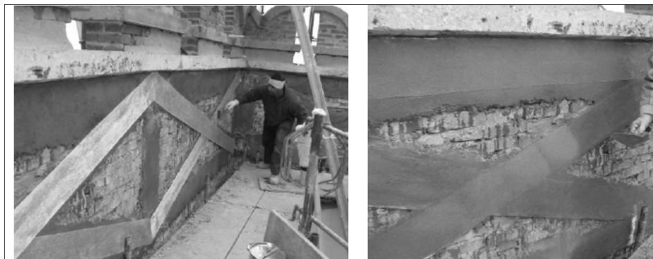
Fig. 2.19 – Consolidamento di pannelli murari, Castrum Voltae, Volta Mantovana (MN) [2.33]
