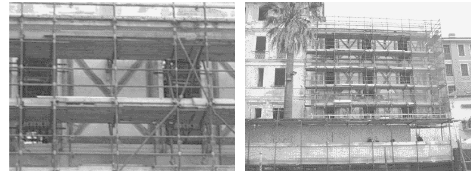
Fig. 2.18 – Consolidamento delle murature portanti di un edificio con FRP [2.24]
