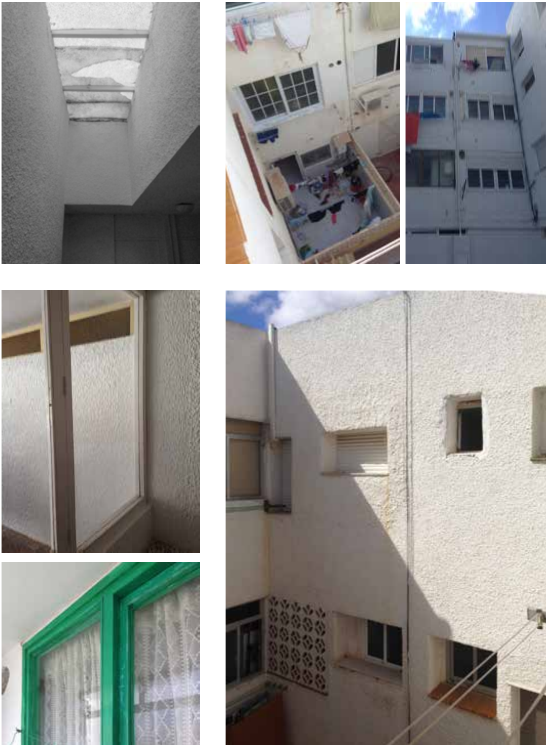
Figura 3.10.20 Fotografías de los patios, del interior y de las carpinterías del Edificio Escalonado Babilonia en la inspección realizada en agosto de 2016 por el autor
