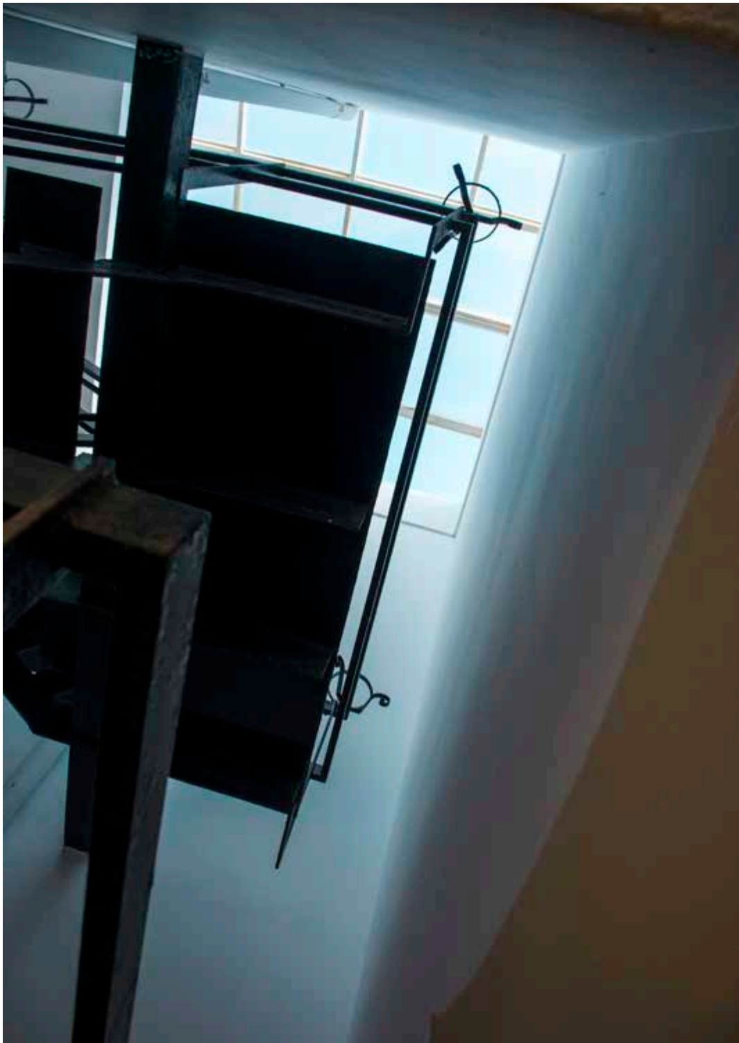
Figura 3.9.15 Vista cenital de la escalera metálica y el patio donde se ubica. Arriba el lucernario actual, modificado tanto en posición como en acabado respecto al proyecto. Foto del autor
