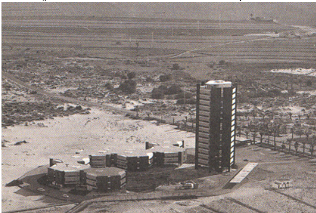
Figura 3.6.2 Imagen histórica del conjunto hexagonal. Arquitecto Antonio Bonet Castellana. Imagen de la época de construcción, en 1965. Fuente Docomomo Ibérico
