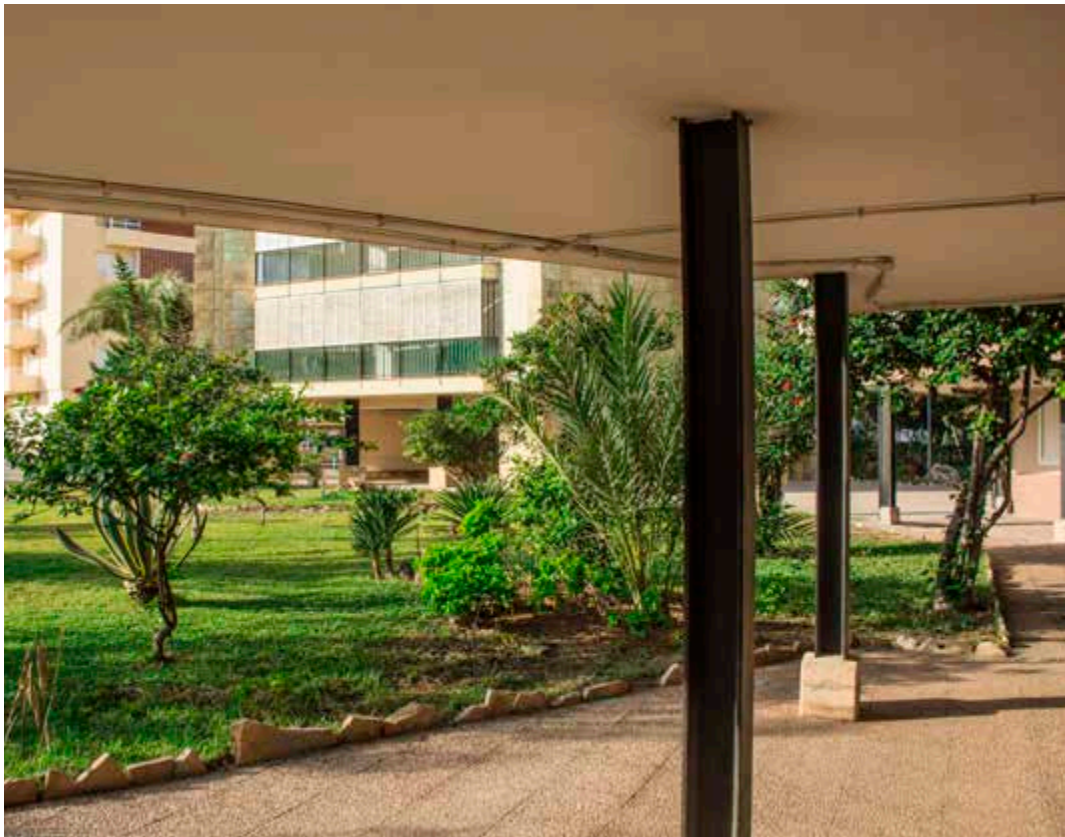
Figura 3.9.6 Fotografía de la planta baja diáfana de uno de los bloques del basamento. Estado actual, (22/5/2016). Fuente: el autor
