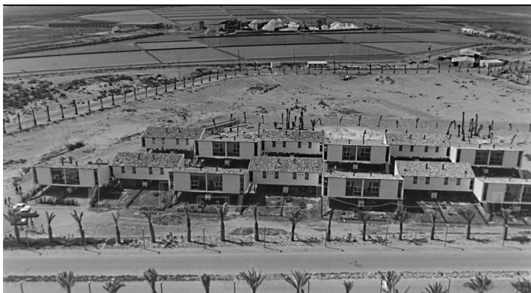
Figura 3.6.1 Conjunto de viviendas Maralet. Arquitecto Antonio Bonet Castellana. Imagen de octubre de 1965. Fuente: Archivo fotográfico La Manga del Mar Menor
