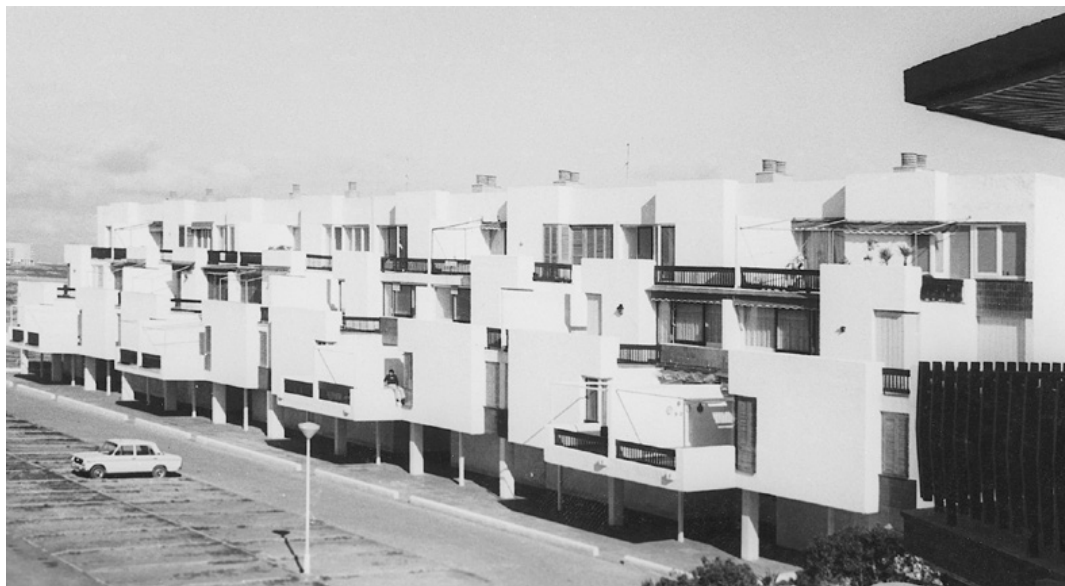
Figura 3.10.2 Fotografía histórica del edificio escalonado Babilonia. Arquitecto: Antonio Bonet Castellana (Ródenas García, 2015)
