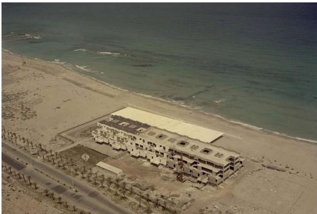
Figura 3.6.4 Imagen histórica del edificio escalonado Babilonia. Arquitecto Antonio Bonet Castellana. Imagen de la época de construcción. Fuente Docomomo Ibérico
