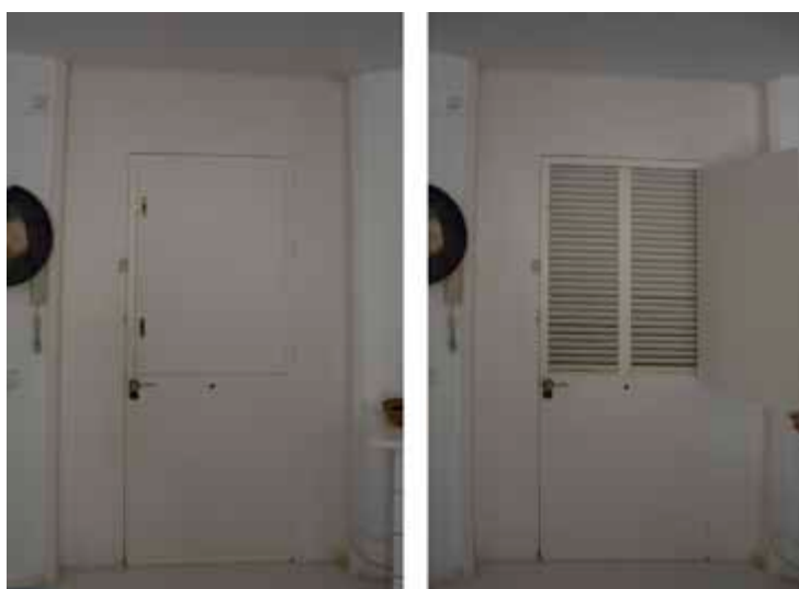
Figura 3.8.5 Arriba, fotografía del rellano, con puertas de acceso a viviendas y ascensores. Abajo, fotografía de la puerta de acceso a la vivienda desde el interior, cerrada y abierta para ventilación cruzada. Fuente: el autor
