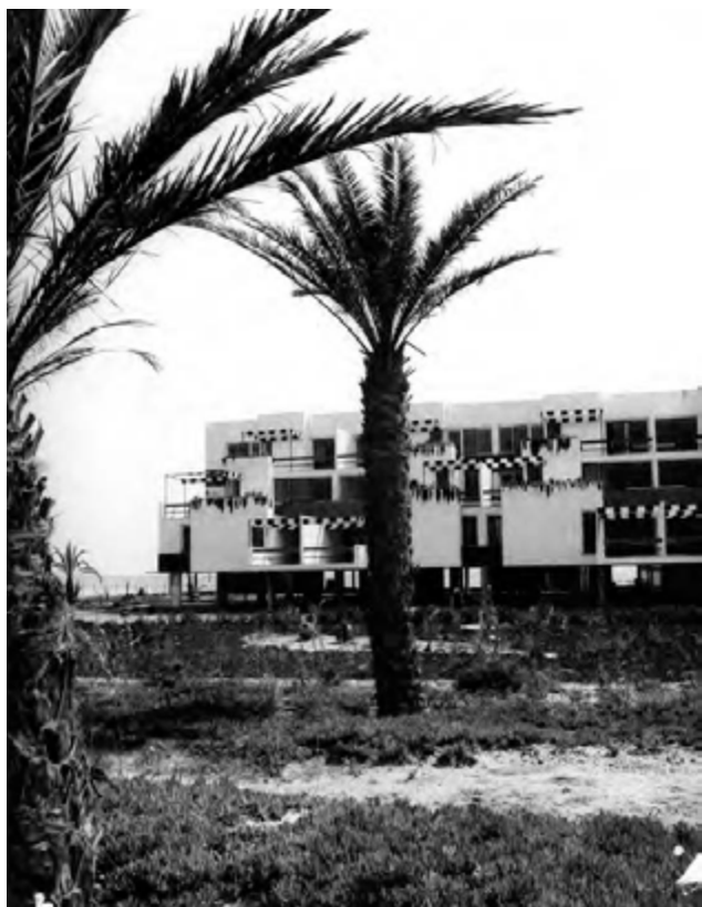
Figura 3.10.1 Fotografía histórica del edificio escalonado Babilonia. Arquitecto: Antonio Bonet Castellana (Ródenas García, 2014)
