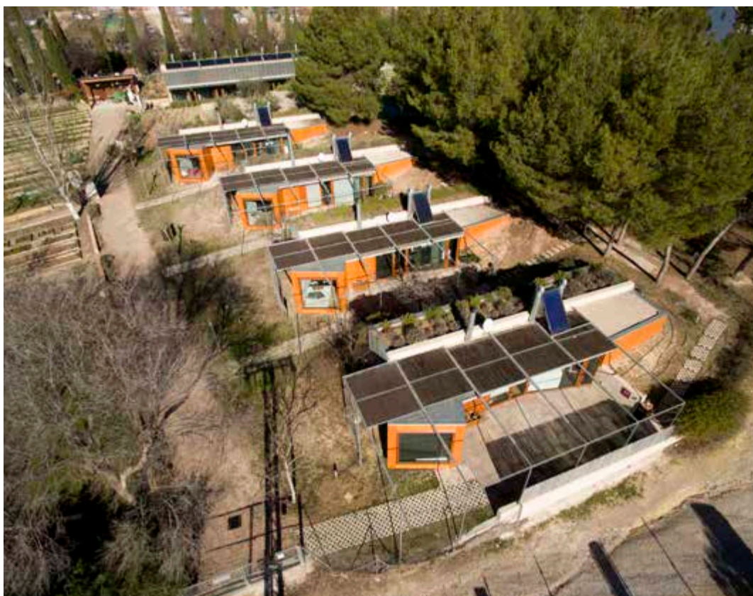
Figura 2.2.5. Centro de Agroecología y Medio Ambiente de Bullas, 2007. Arquitecto Fernando de Retes Aparicio. Foto Damián Guirado Escámez, diciembre de 2016.
