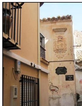
FOTO 32. Ojós. Cartel informativo de ruta urbana.
