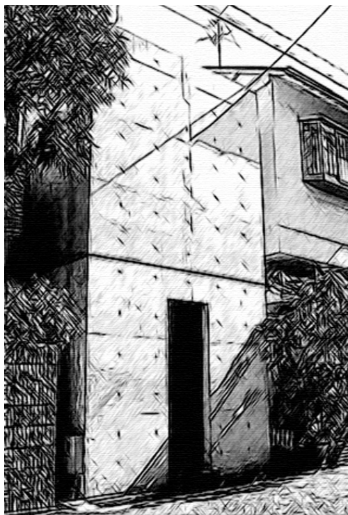
Figura A.1.2: Fachada principal.
