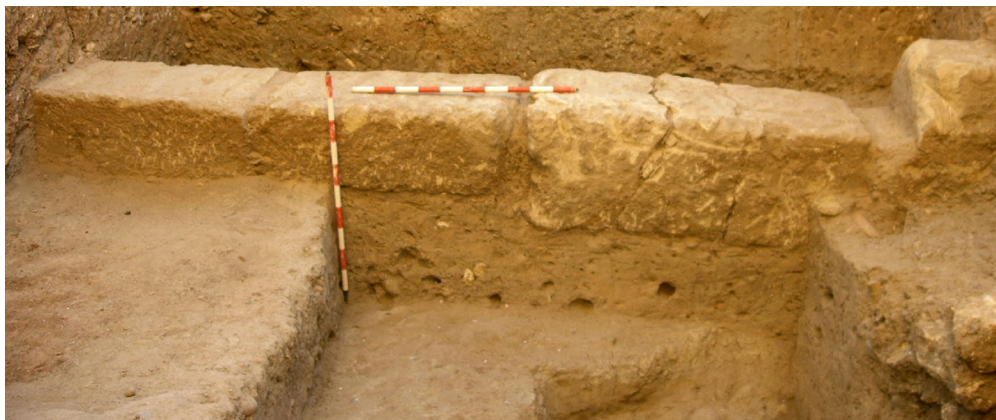
Fig. 6. Av. Ronda de Isasa, 4: fracturas y buzamiento en la cimentación de un paramento (García y Osuna, 2005: lám. 25).
