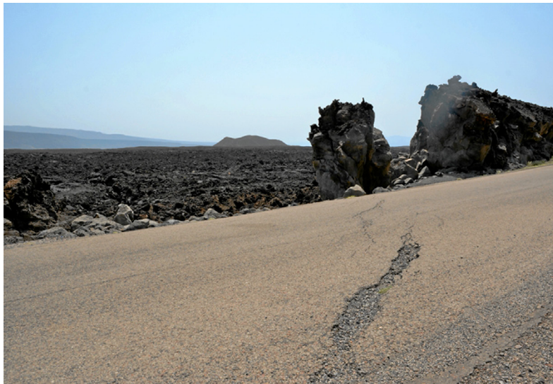
Fig. 5. La tectónica global, como paradigma explicativo de las modernas Ciencias de la Tierra, representa una de las nociones fundamentales en la comprensión del mundo. Carretera de Djibuti constantemente deteriorada por la actividad del Rift Assal-Ghoubet entre las placas africana y árabe.
