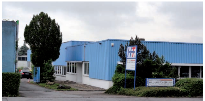
Je größer die Hallen und je wärmer die Innentemperatur, umso mehr Energie kann eingespart werden.
