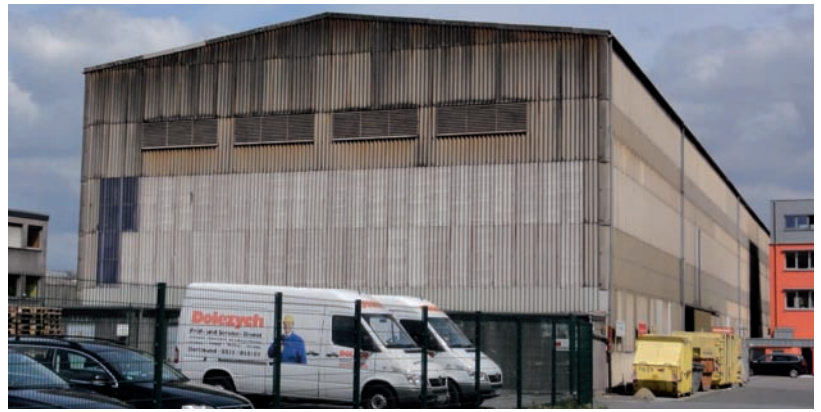
Die oft schon älteren Produktionshallen bringen eine Menge Sanierungsmöglichkeiten mit sich.
