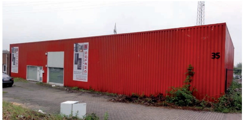
Durch vorgesetzte weitere Elemente können solche Hallen wirkungsvoller gedämmt werden.
