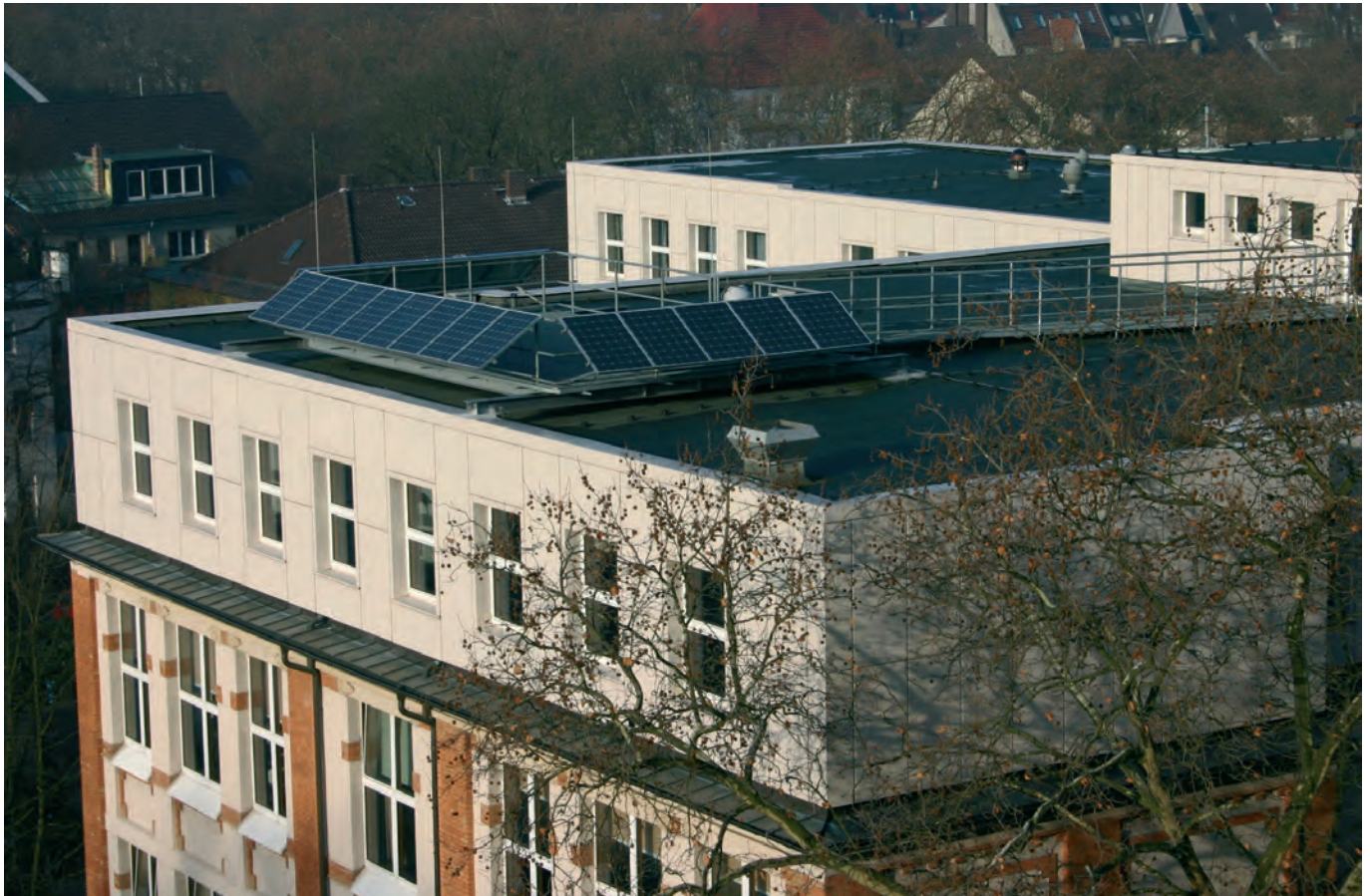
Auf dem Dach der Fachhochschule bilden rund 20 Solarmodule den Outdoor-Messstand für Forschung und Lehre.
