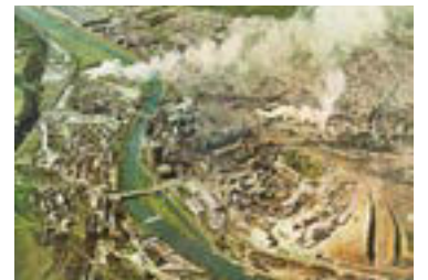
Luftbild der Völklinger Hütte schätzungsweise aus den 1970er Jahren 3
