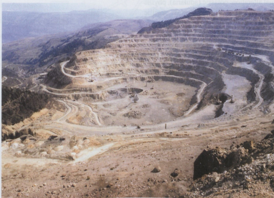
Fig. 24. Roșia Poieni open pit.
