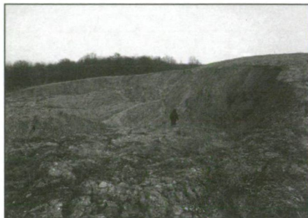
7. ábra: Az Ádám-völgyi meddőhányó ÉK-i oldalán kiújult csuszamlás szakadásfala
