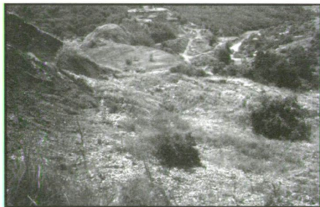
5. ábra: A szakadással előterében összezsúszott meddőanyag és a természetes völgyoldal hepe-hupás felszíne
