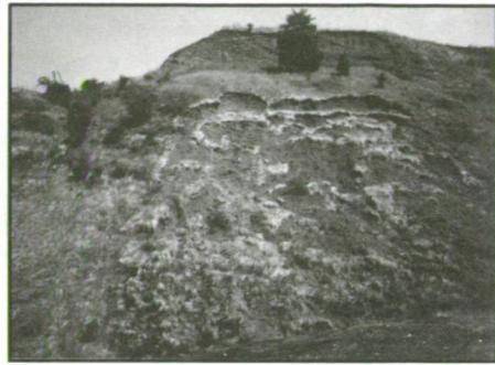
3. ábra: Köpenycsuszamlás az Ádám-völgyi meddőhányó fő kúpjának K-i rézsüoldalán
