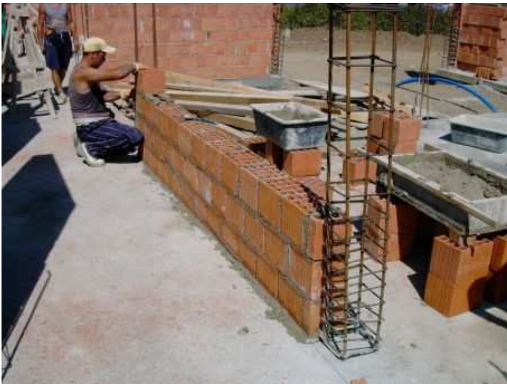
Figura 1: Foto di cantiere nella provincia di Mitrovica (Kosovo)
