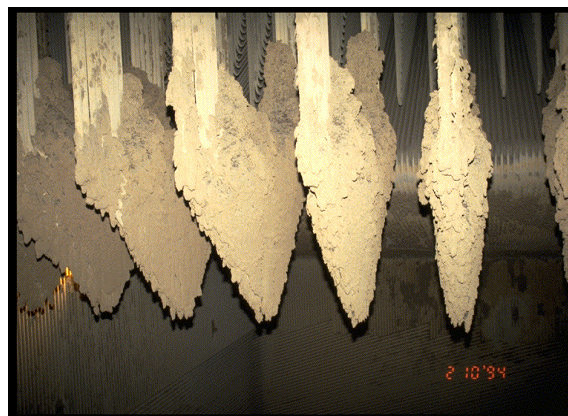
Figura 9: depositi di materiale inorganico sui fasci tubieri.
