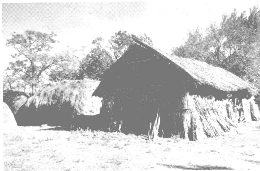
2. Nádtetős dohánypajta, szélfogóval körülámasztva
