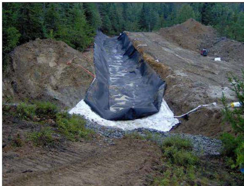
Figure 6.7 Mise en place de la géomembrane
