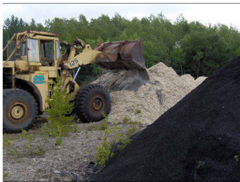
Figure 6.11 Mélange des matériaux avec une chargeuse
