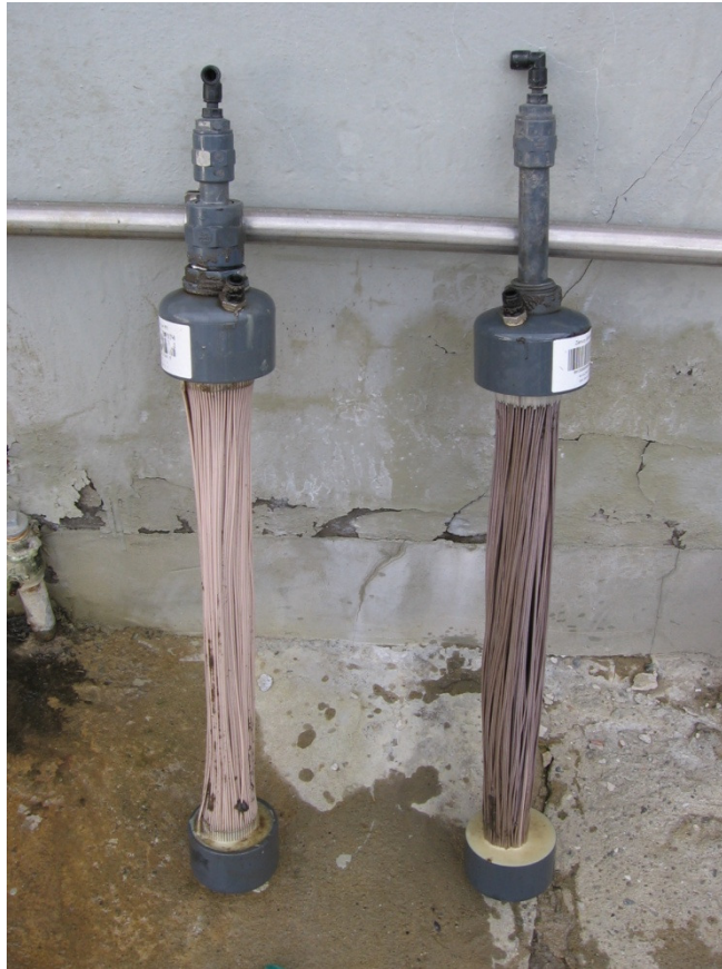
Membrane prime dell'operazioni di pulizia
