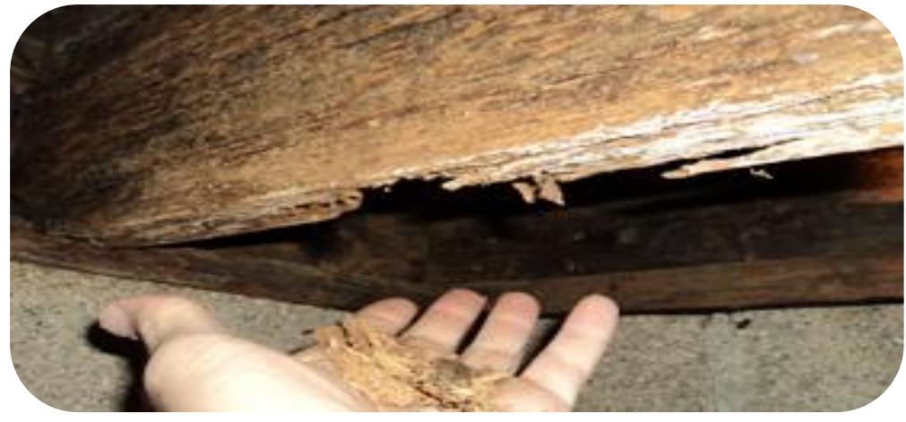
Fig. 2 Wood damage caused by Coniophora puteana . Sachverständigenbüro für Holzschutz, 2016.
