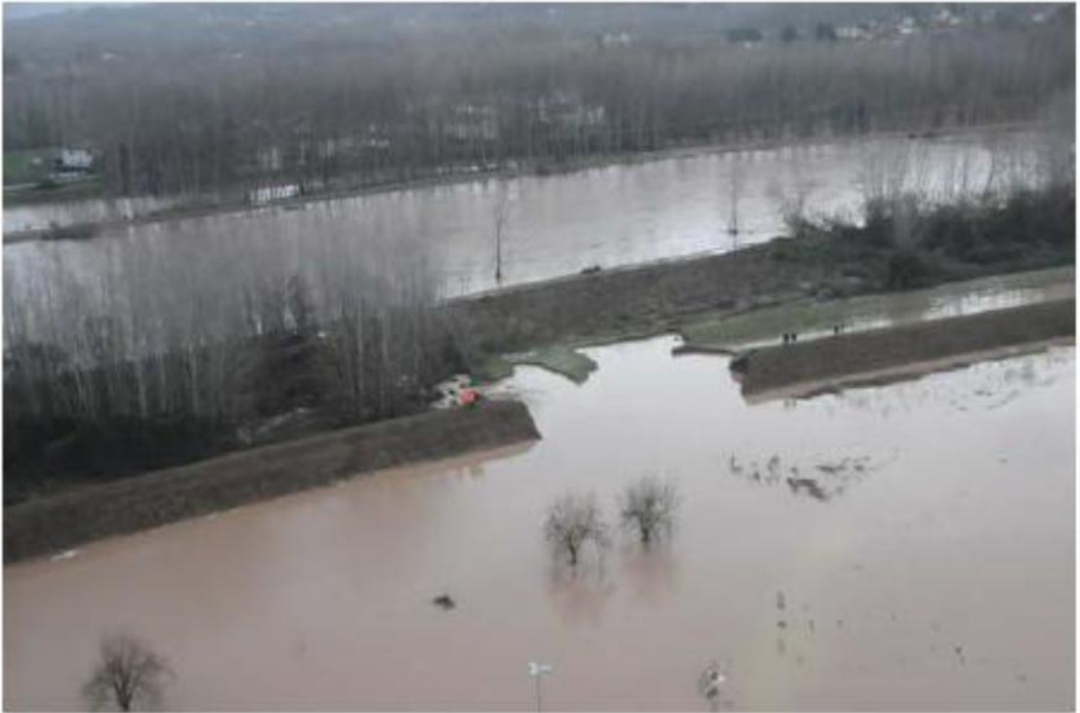
Figura 18. Breccia a valle della bretella autostradale
