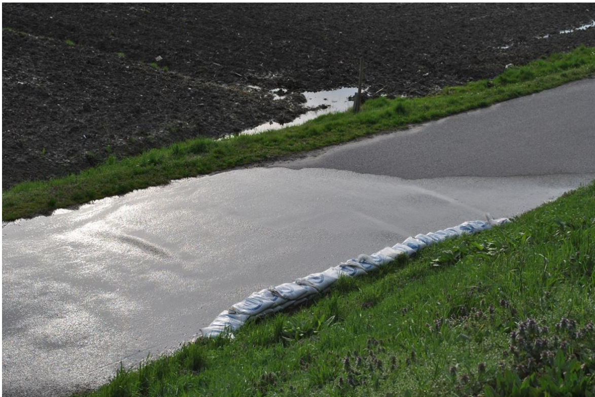
Figura 8. Fontanazzo sul Bacchiglione a Pontelongo (PD)
