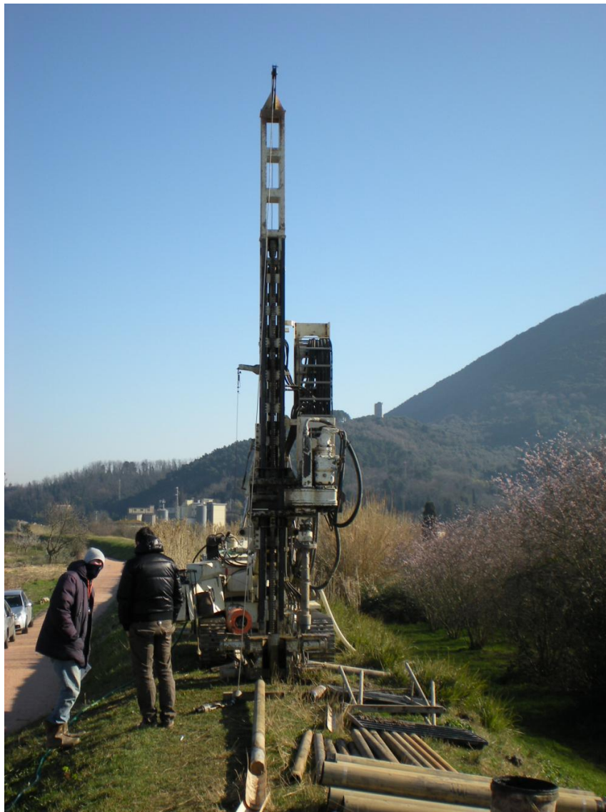
Figura 26. Realizzazione di un sondaggio
