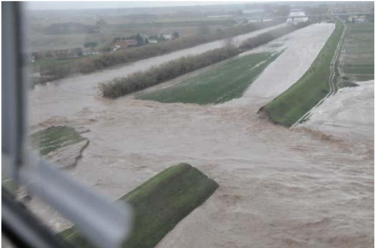
Figura 19. La breccia di Nodica
