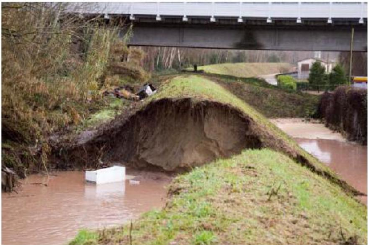
Figura 17. Breccia a monte della bretella autostradale
