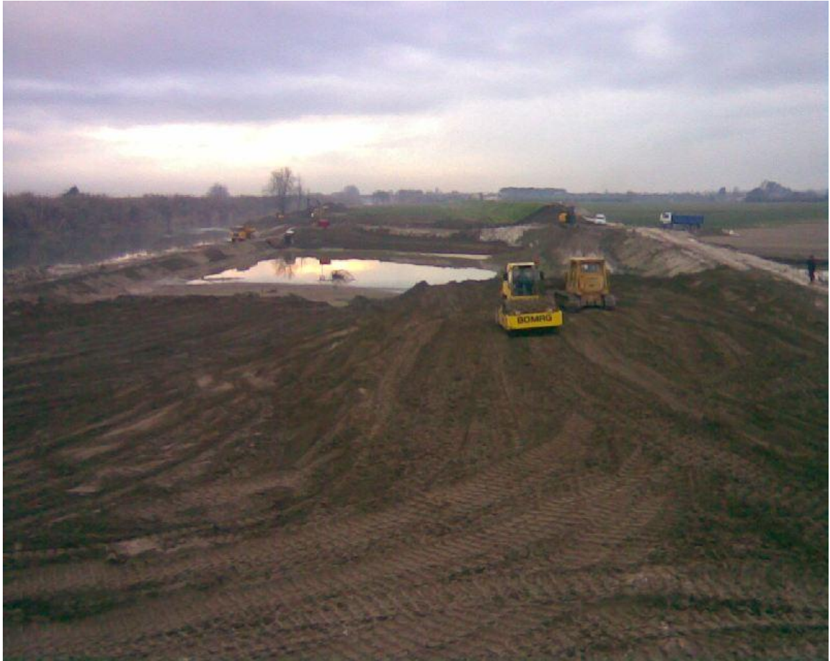
Figura 23. Interventi di urgenza sulle rotte a Nodica
