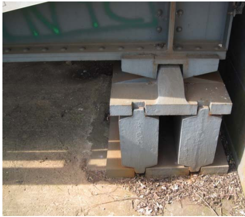
Figure 4.7 - Ponte sul Panaro: Dettaglio dell'appoggio mobile
