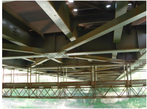
Figure 4.6 - Ponte sul Panaro: Dettaglio delle aste di intradosso
