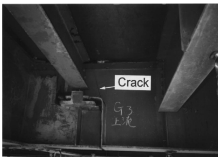
Fig. 1.15 - Esempi di fratture per fatica in ponti Giapponesi [9].
