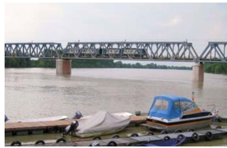
Fig. 1.3 – Ponte reticolare chiodato a travata sul Po [2]
