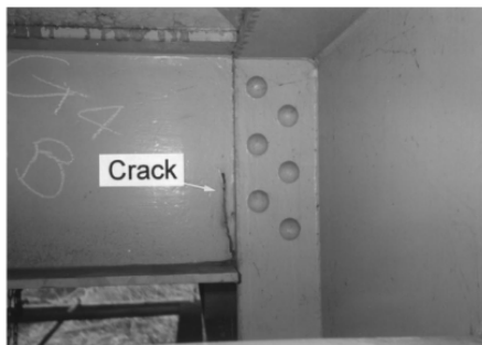
Fig. 1.13 - Danneggiamenti per fatica tipici del collegamento trave principale - traverso
