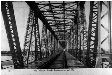
Fig. 1.3 – Ponte reticolare chiodato a travata sul Po [2]
