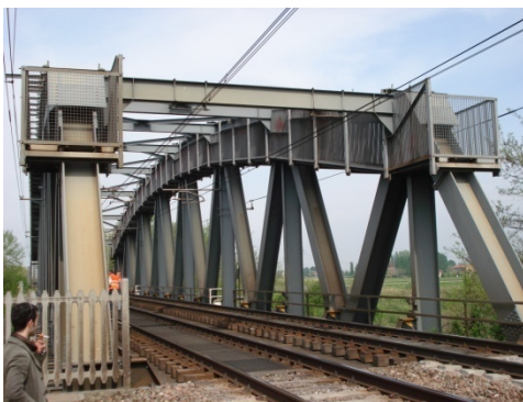
Fig. 4.3 - Vista generale del ponte sul Panaro
