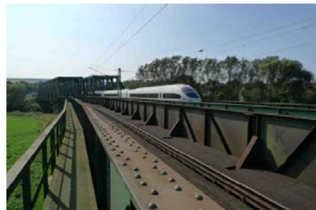
Fig. 1.4 – Ponte a travi parallele a parete piena presso Naumburg (Germania) [2]
