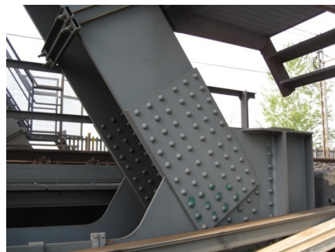
Figure 4.4 - Ponte sul Panaro: Dettaglio di un collegamento chiodato
