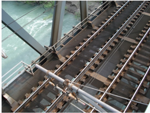
Figure 4.5 - Ponte sul Panaro: Dettaglio del piano del ferro
