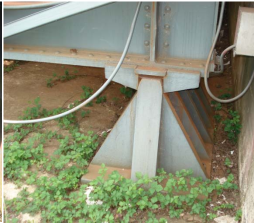
Figure 4.8 - Ponte sul Panaro: Dettaglio dell'appoggio fisso
