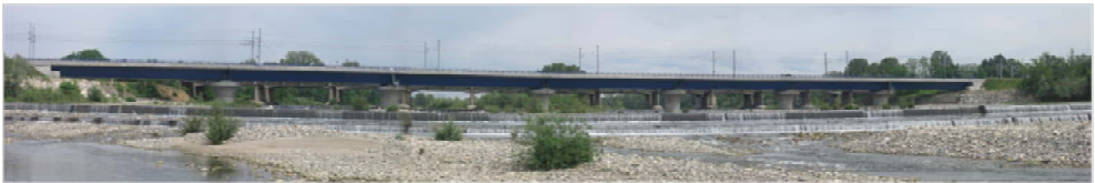
Fig. 4.1 - Vista generale del viadotto Sesia
