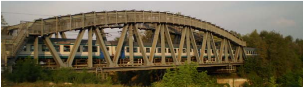
Fig. 4.1 - Immagine del ponte sul Panaro (per gentile concessione di RFI).
