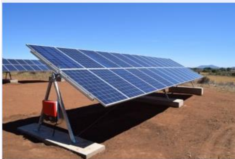
Figura 2.12: Sistema de seguimiento de un eje azimutal. 19
