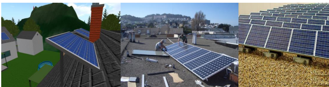
Figura 2.1: Paneles solares adosados en el techo, loza y en una base en la tierra. 4
