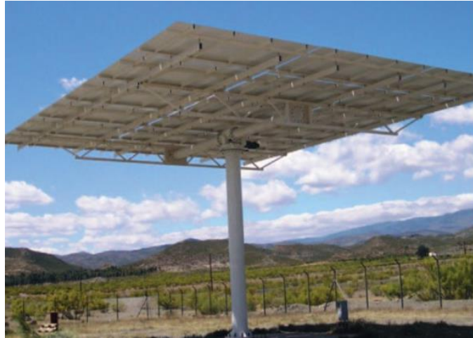
Figura 2.14: Sistema de seguimiento de dos ejes en monoposte. 21
