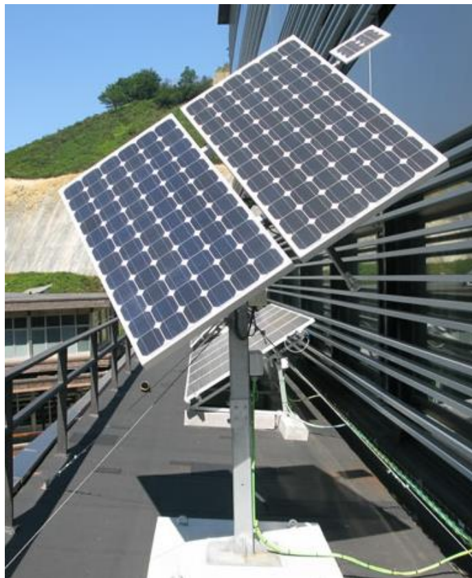
Figura 2.17: Sistema de seguimiento, con mini panel para alimentación del mecanismo del seguidor. 24
