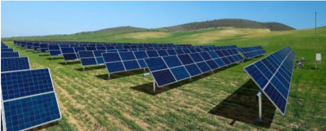
Figura 2.13: Sistema de seguimiento de un eje horizontal. 20
