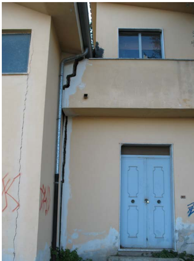
Figura 39 :Testata di frana. Canonica della chiesa dell'Annunziata (foto Novembre 2006).
