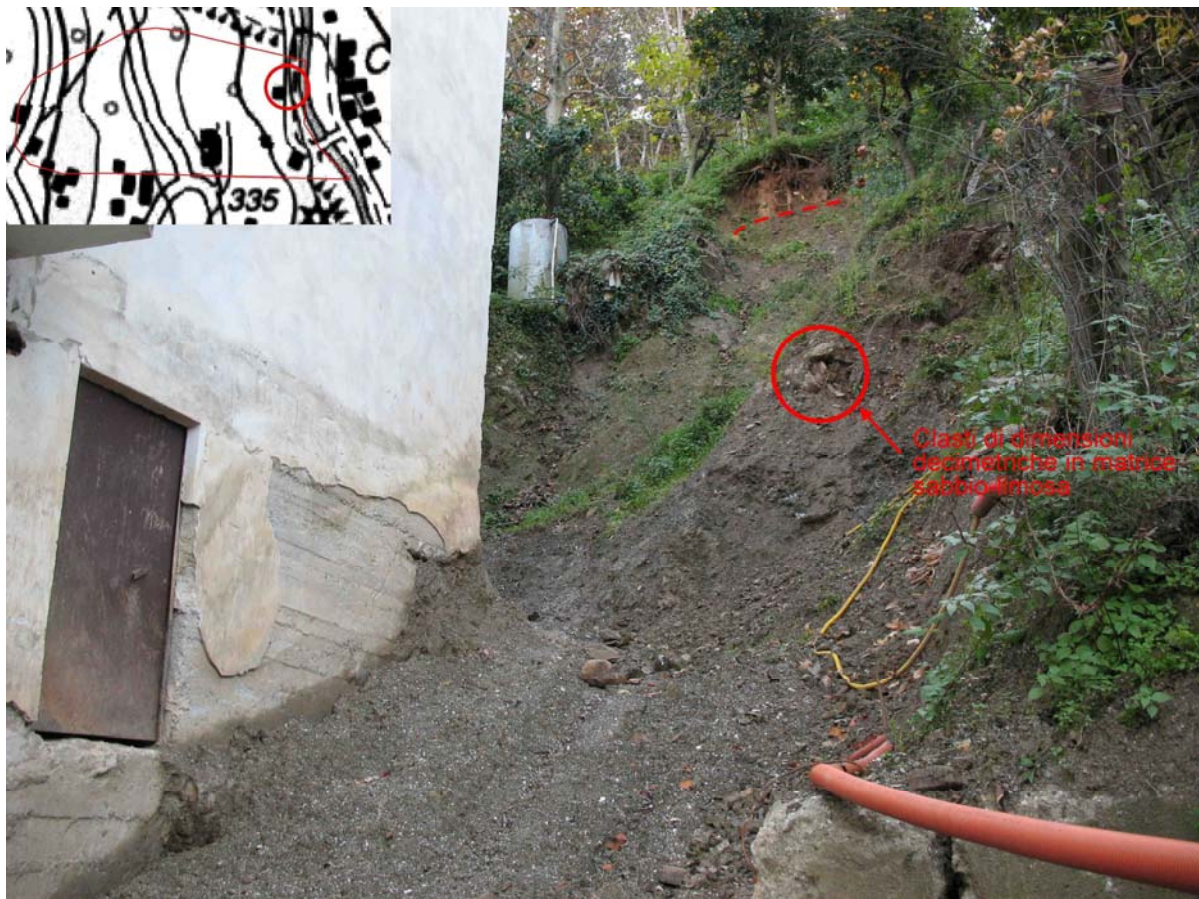
Foto 37: Piede della Frana. Versante quasi verticale a ridosso di un edificio gravemente danneggiato. Da notare la natura eterometrica del materiale coinvolto nel movimento (foto Novembre 2006) .
