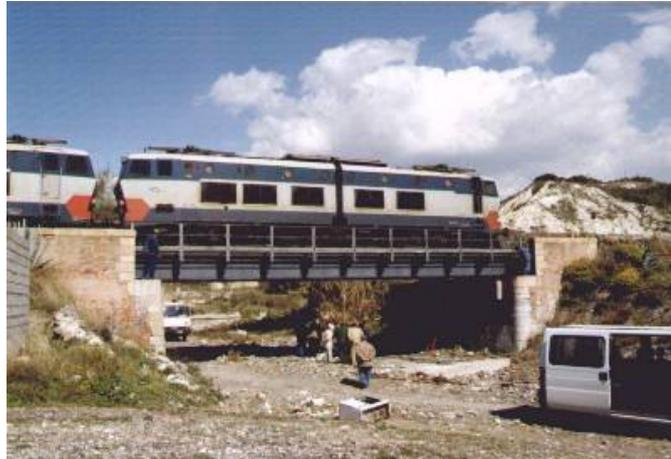
*Fig. 4.24 Prove di carico su un ponte definitivo realizzato con travi gemelle*
