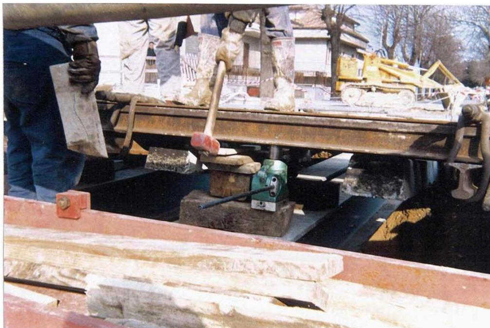
*Fig. 4.16 Travi di manovra. Regolazione dell'assetto del binario*
