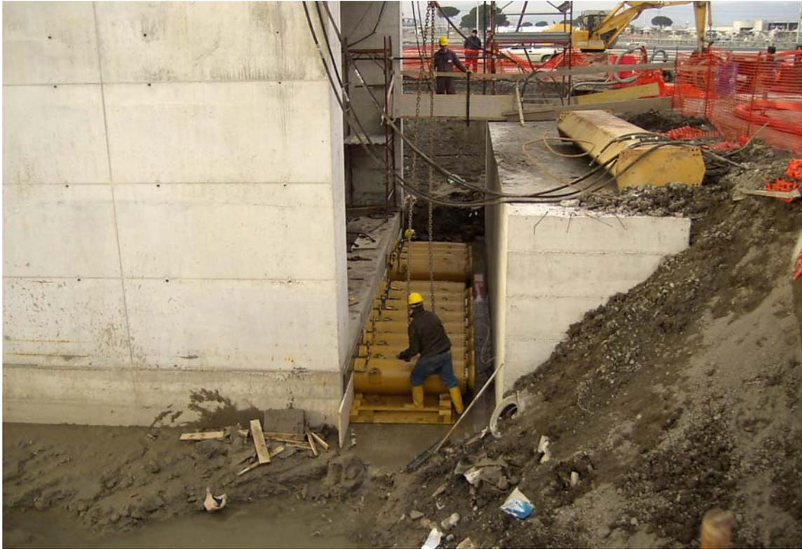
*Fig. 4.2 Posizionamento dei martinetti tra il monolite e il muro reggispinta*
