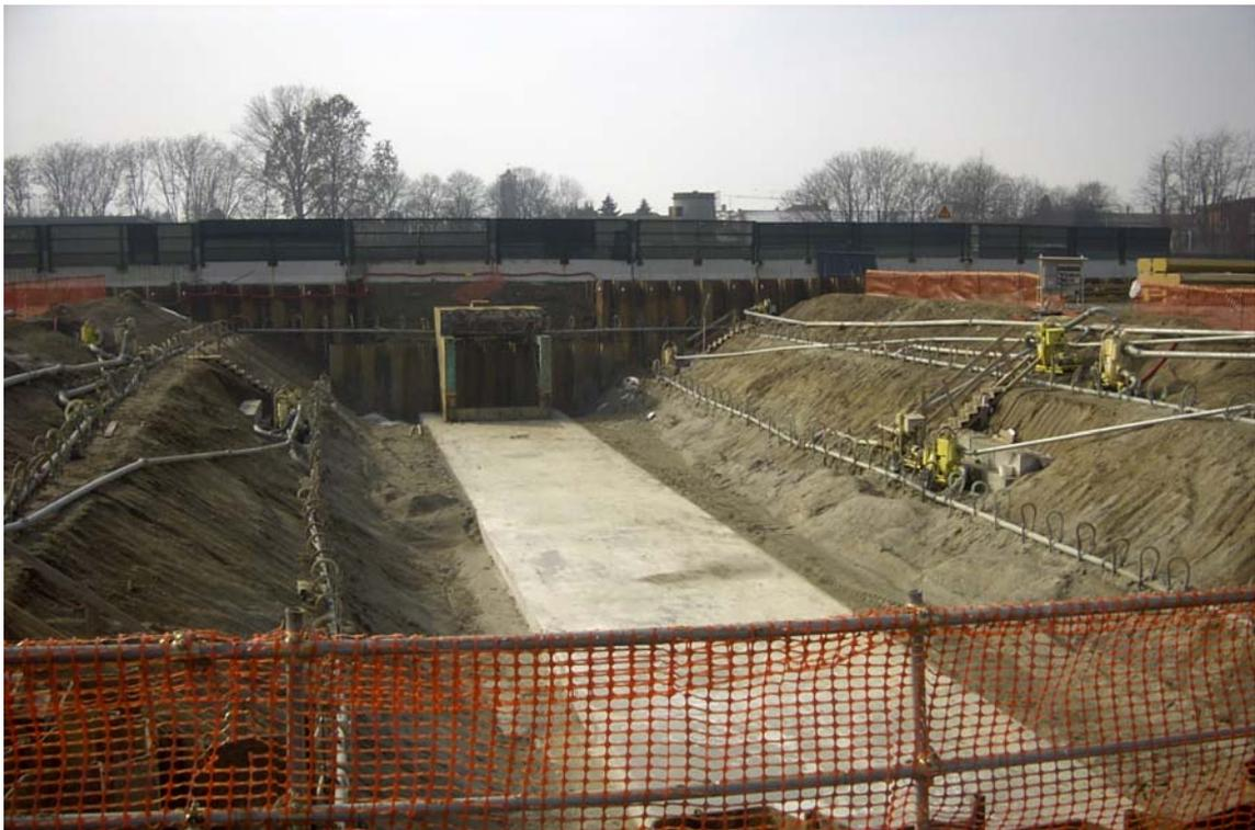
*Fig. 4.1 Platea di varo. Si nota il sistema di suzione dell'acqua*
