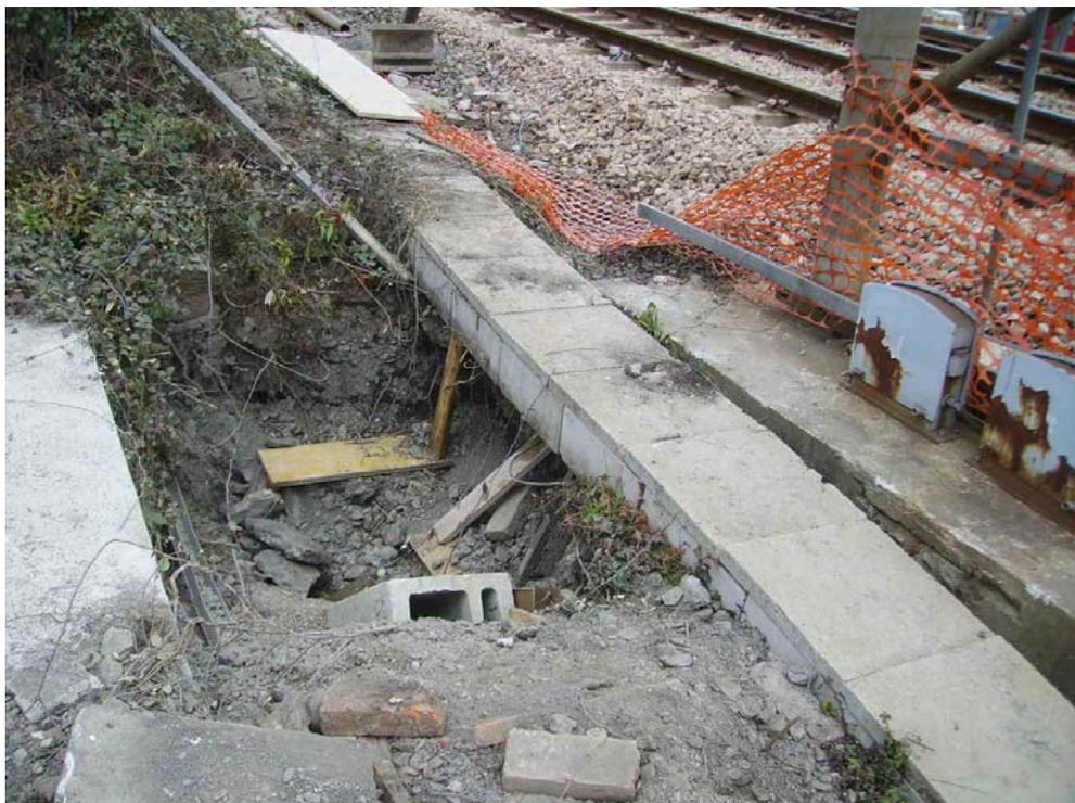
*Fig. 4.60 Abbassamento localizzato del terreno dovuto alla formazione di un "fornello"*
