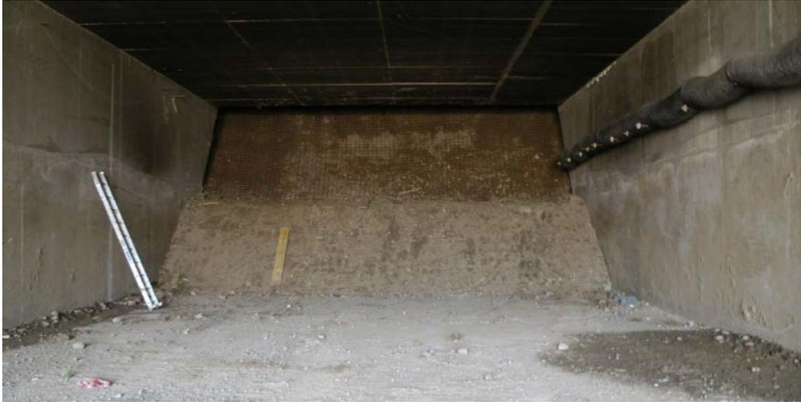
*Fig. 7.1 Consolidamento del fronte di scavo con terreno di riporto per interruzione prolungata dei lavori*
