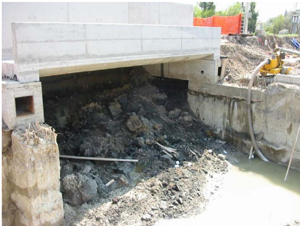
*Fig. 4.43 Cantiere dopo la posa degli impalcati. Sono visibili le travi principali*
