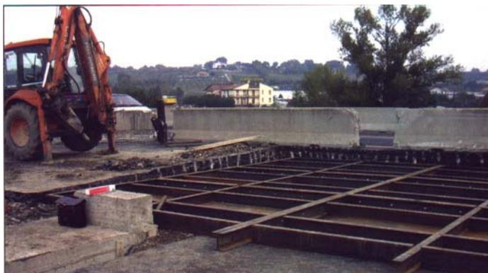
*Fig. 4.45 Piastra antitrascinamento allestita sotto il piano stradale*
