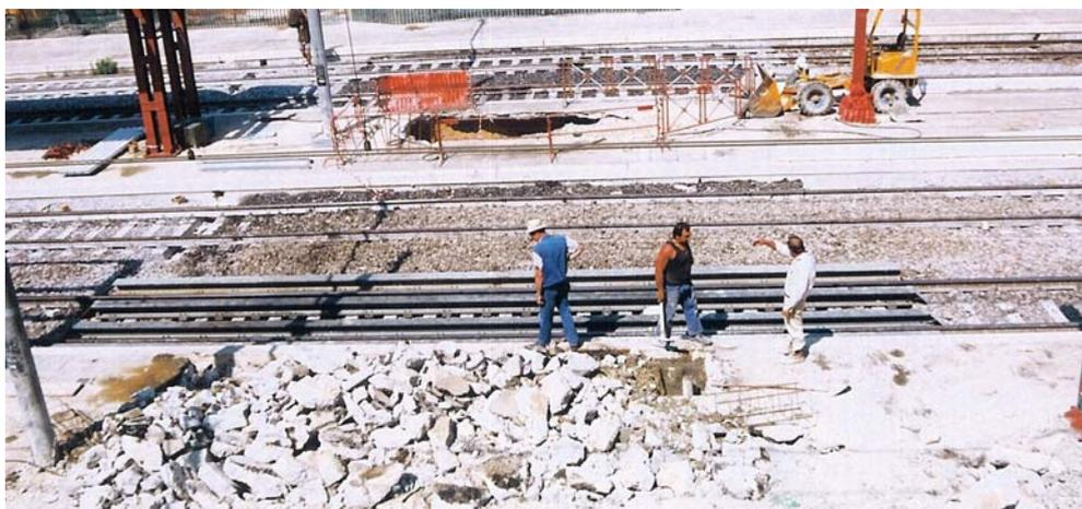
*Fig. 4.28 Porzione di binario armato con travette*
