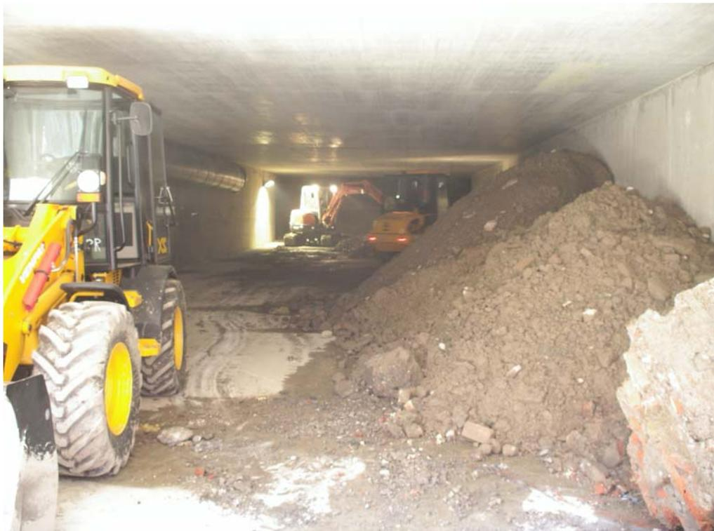
*Fig. 4.63 Accumulo di terreno nel tunnel durante la spinta in attesa dello smarino definitivo*
