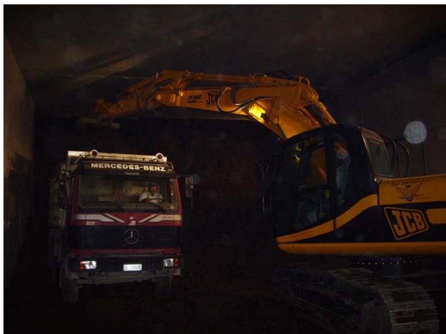
*Fig. 6.4 Caricamento dell’autocarro direttamente con l’escavatore adibito allo scavo*
