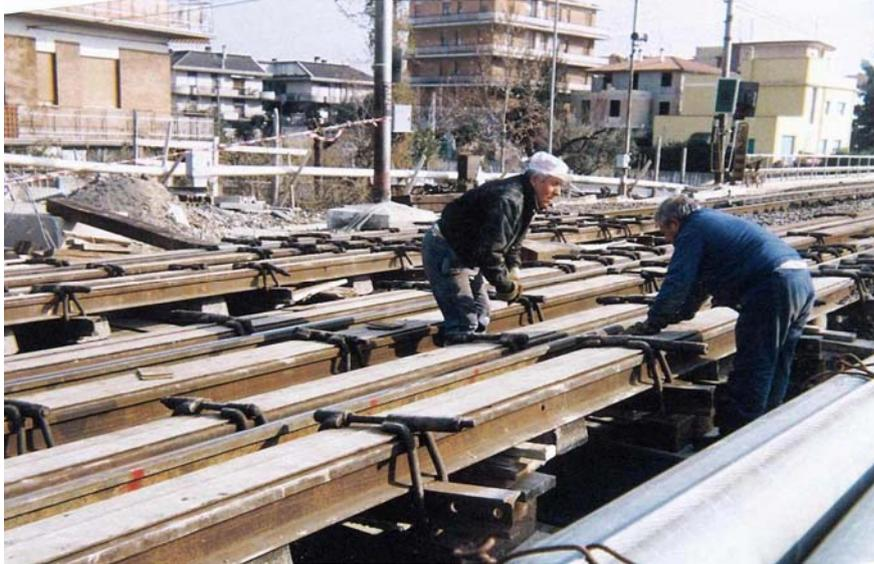
*Fig. 4.17 Installazione dei fasci di rotaie*
