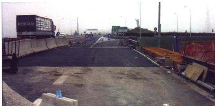
*Fig. 4.47 Manto stradale steso sopra la piastra antitrascinamento*
