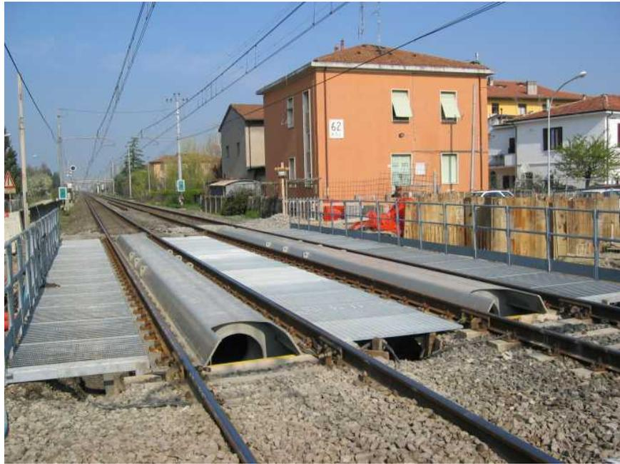
*Fig. 4.26 Ponte Bologna provvisorio in configurazione a doppio binario*
