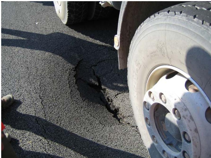
*Fig. 5.5 Avvallamento della superficie stradale*
