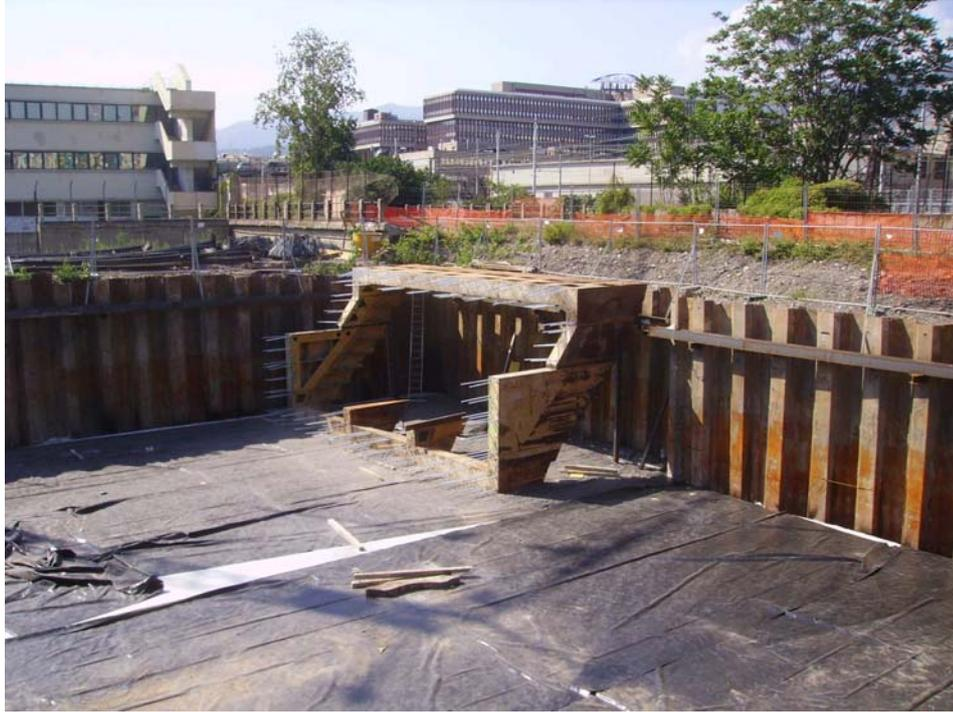
*Fig. 4.56 Montaggio dello scudo sulla platea prima della costruzione del monolite*
