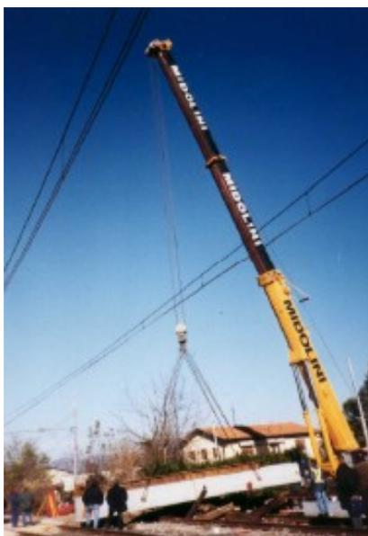
*Fig. 4.42 Posa in opera di un impalcato*
