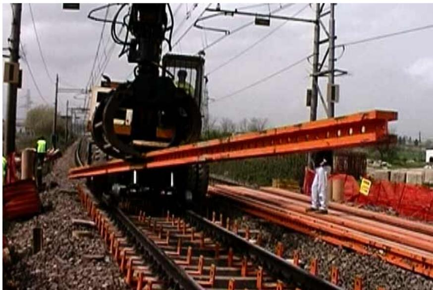
*Fig. 4.30 Posa in opera di una trave Essen. Sono visibili i fori per gli spinotti*
