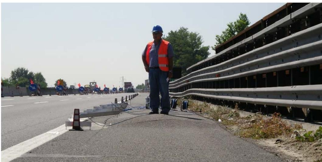
*Fig. 7.3 Deformazione superficiale dovuta alla presenza di un trovante nella zona del tagliante superiore*
