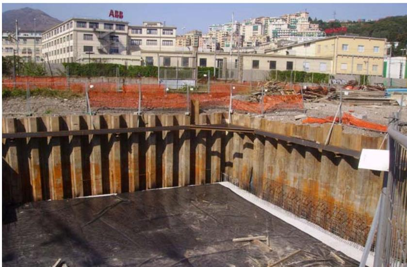
*Fig. 2.2 Palancolato con travi di rinforzo della paratia*
