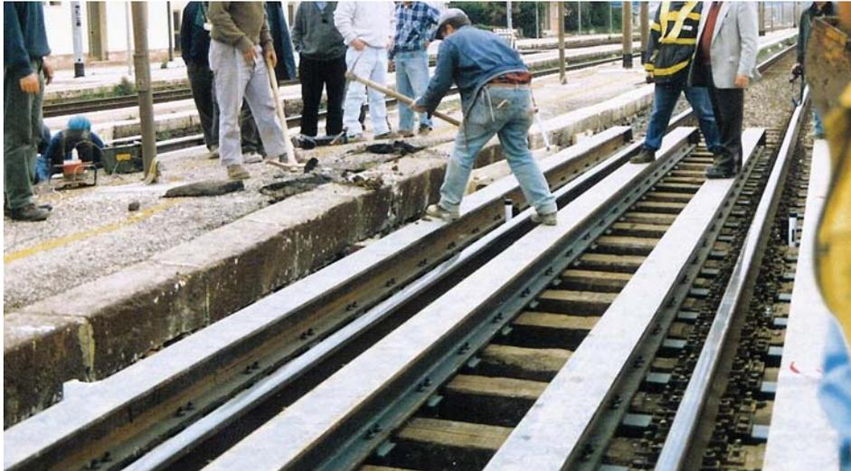
*Fig. 4.27 Binario armato con travette*
