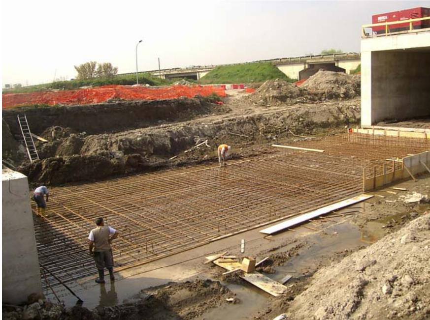
*Fig. 4.7 Armatura del getto di ripresa*
