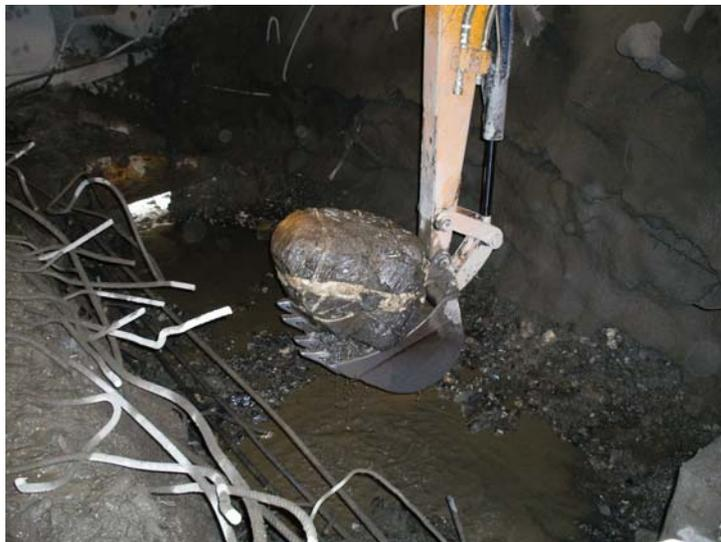
*Fig. 4.61 Rimozione di un trovante dal fronte di scavo*
