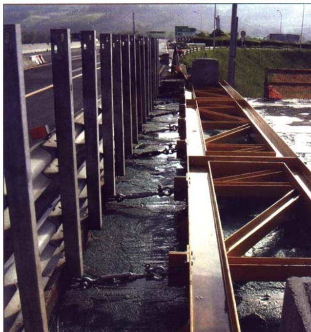
*Fig. 4.46 Tiranti regolabili di collegamento della piastra antitrascinamento alla trave reticolare ancorata a terra*
