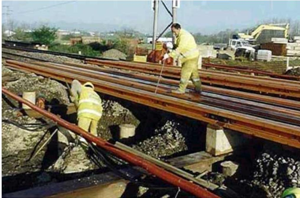
*Fig. 4.33 Pali in legno per l'appoggio delle travi di manovra*
