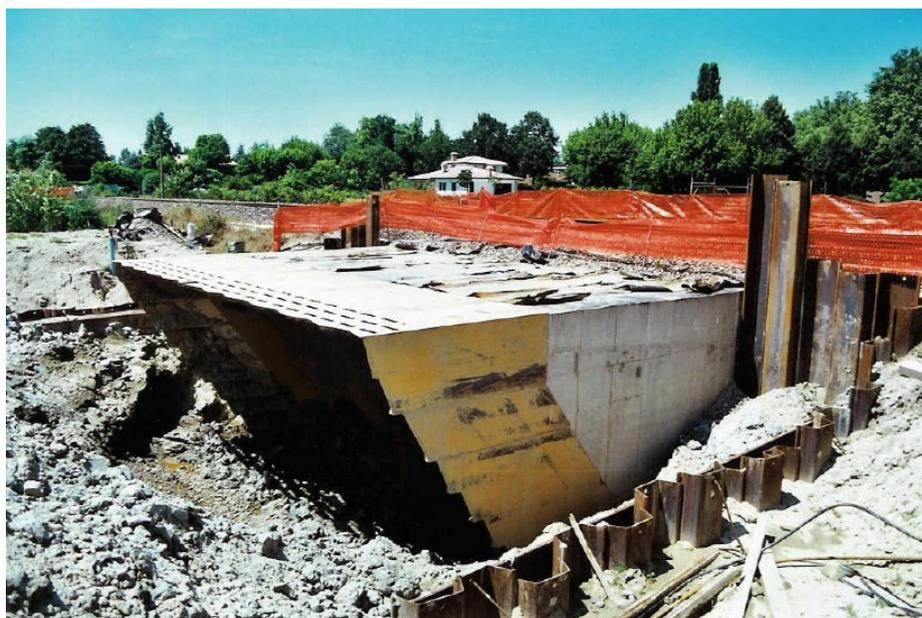
*Fig. 4.51 Scudo e monolite; una parte del rostro è in cemento armato*
