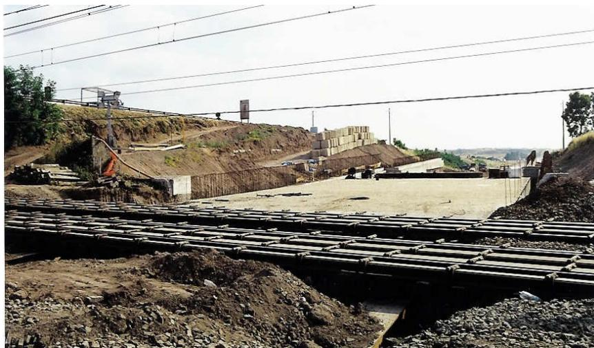
*Fig. 4.18 Fasci di rotaie tipo “Garutti” in opera*
