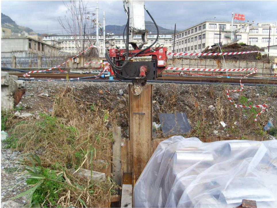
*Fig. 6.11 Infissione della palancola con vibrazione della pinza*
