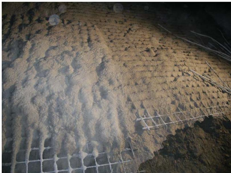
*Fig. 7.2 Consolidamento del fronte di scavo con “spritzenbeton”*
