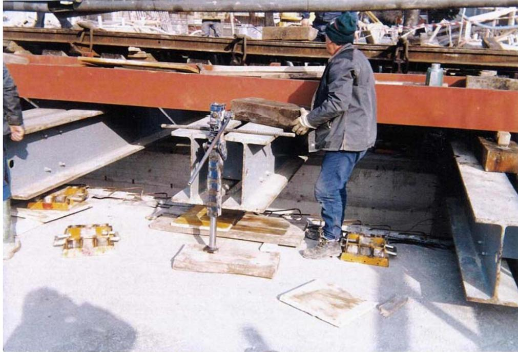
*Fig. 4.15 Travi di manovra e rulli di scorrimento prima dell'inizio della spinta*
