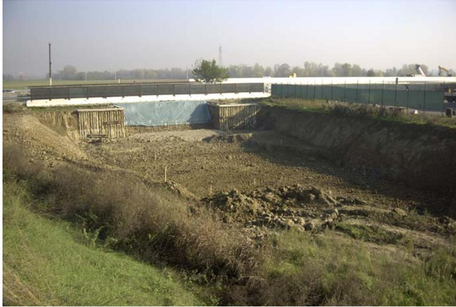
*Fig. 2.1 Trincea di varo realizzata in parte con scavo non protetto e in parte con scavo protetto da micropali*
