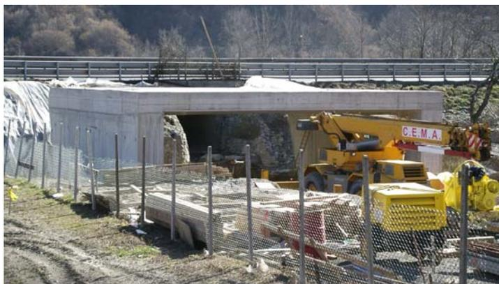
*Fig. 4.48 Metà di monolite pronta alla spinta. Si nota il ricoprimento molto basso*
