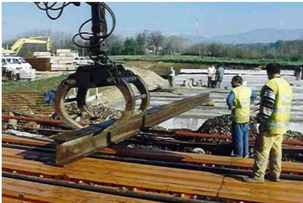
*Fig. 4.34 Installazione delle travi di manovra*
