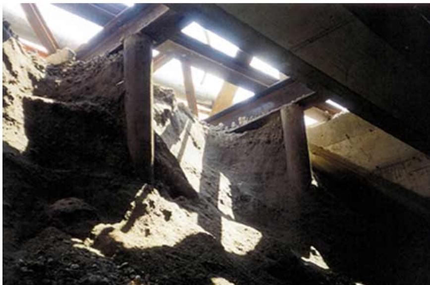
*Fig. 4.36 Pali in legno messi in luce dallo scavo durante l'avanzamento*
