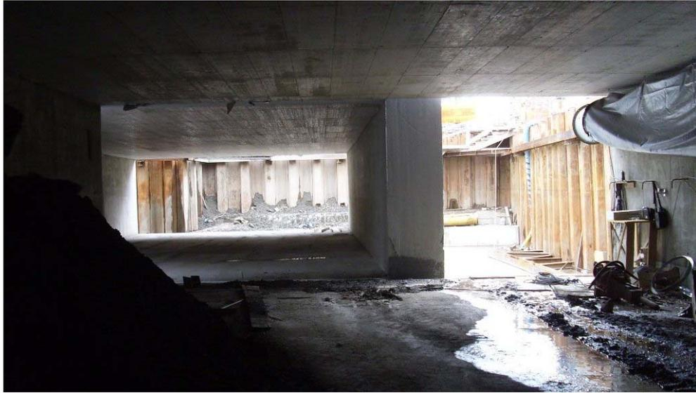
*Fig. 4.13 Il terzo concio visto dall'interno del secondo durante la traslazione*
