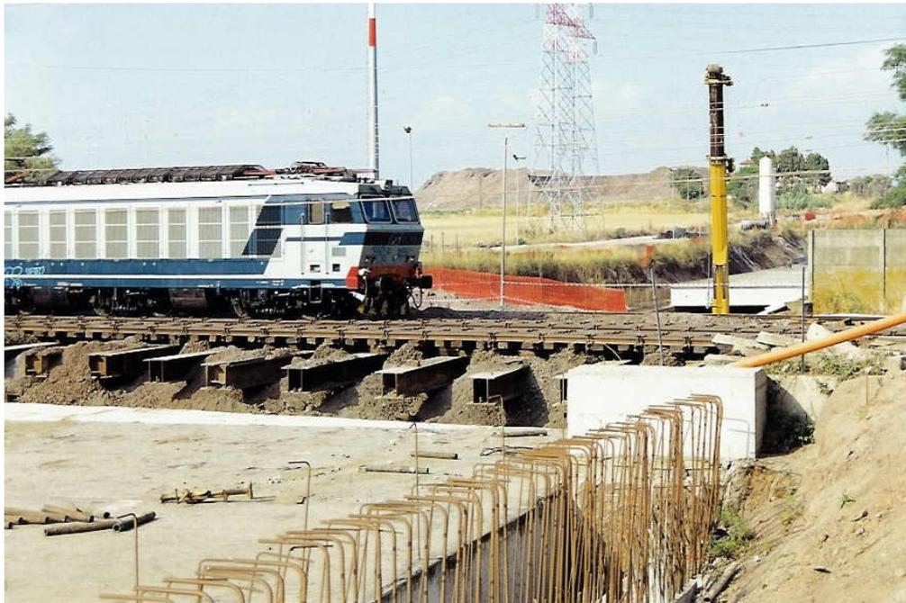
*Fig. 4.14 Travi di manovra pronte all'uso prima della spinta del monolite*
