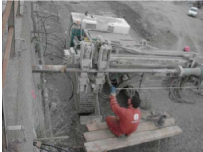
*Fig. 6.12 Infissione orizzontale di un micropalo con tubo camicia*
