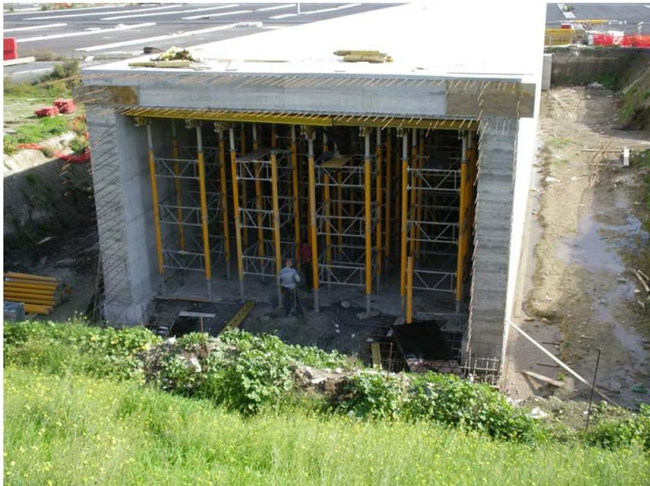
*Fig. 4.57 Monolite costruito prima del montaggio dello scudo. Si notano i ferri di collegamento alle armature del getto di chiusura*
