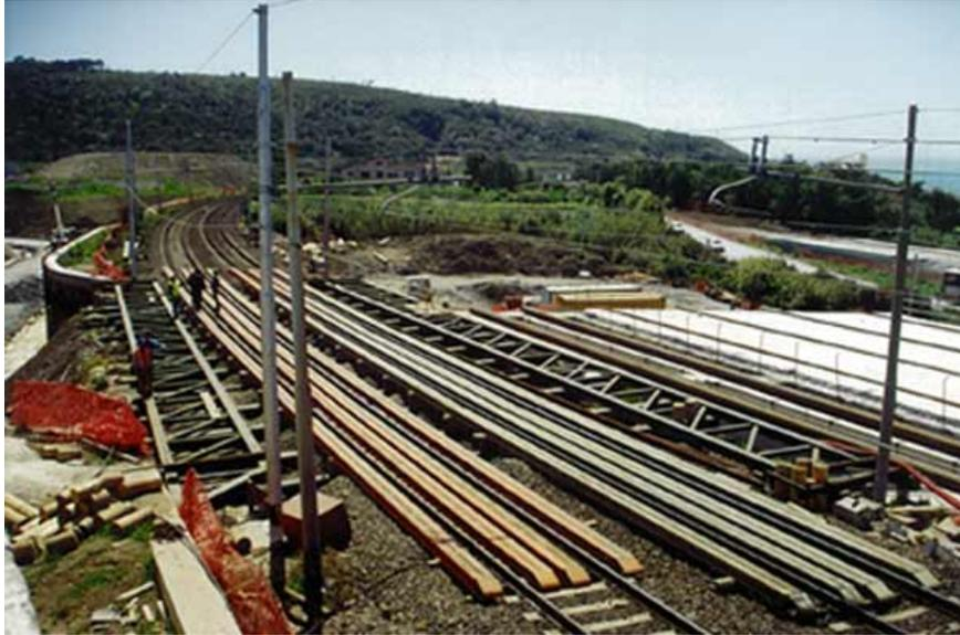
*Fig. 4.35 Sistema Essen con travi di vincolo reticolari*
