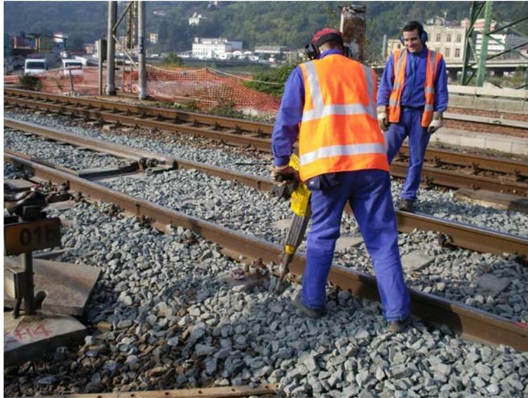
*Fig. 6.21 Rincalzatura manuale con martello vibrante*
