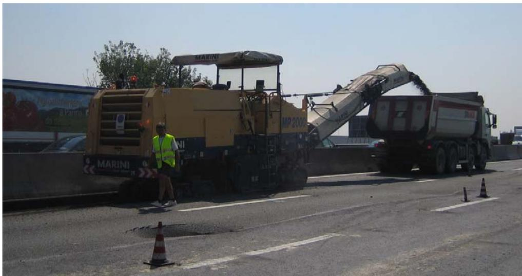
*Fig. 6.22 Macchina scarificatrice*
