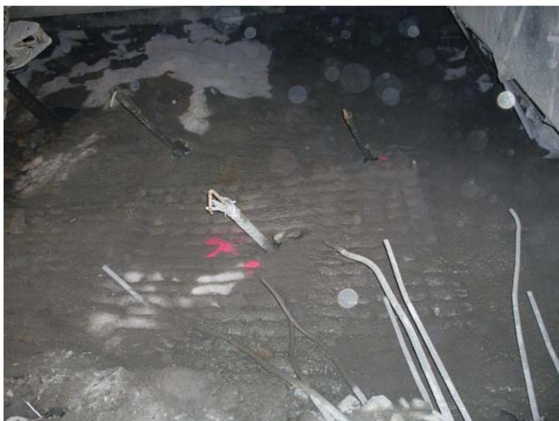
*Fig. 6.14 Micropali obliqui in vetroresina con tondino di armatura per il consolidamento di un fronte di scavo*
