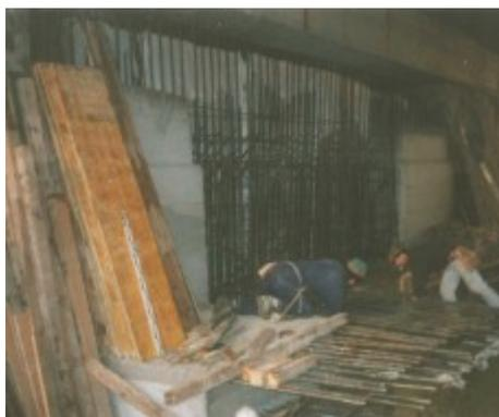
*Fig. 4.44 Realizzazione delle pareti laterali in sottomurazione. E' visibile in alto una trave principale*
