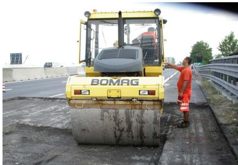
*Fig. 6.25 Compattatore vibrante utilizzato per costipare il binder prima dell'asfaltatura*
