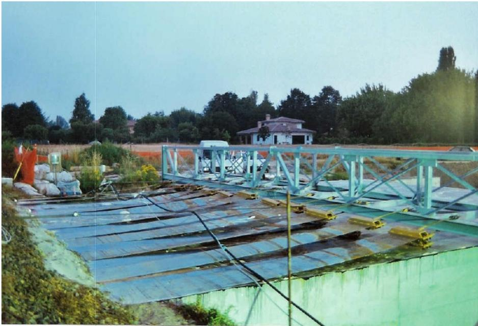
*Fig. 4.55 Nastri ancorati alla trave “regginastri” durante la spinta del monolite*
