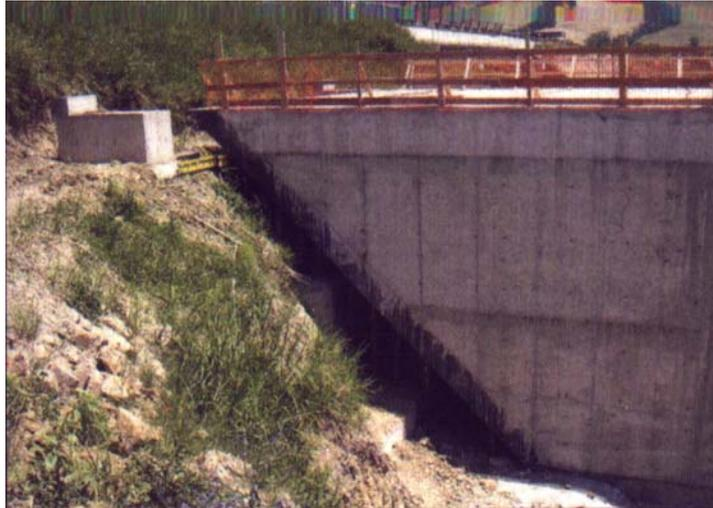
*Fig. 4.11 Parte anteriore del monolite con rostro*
