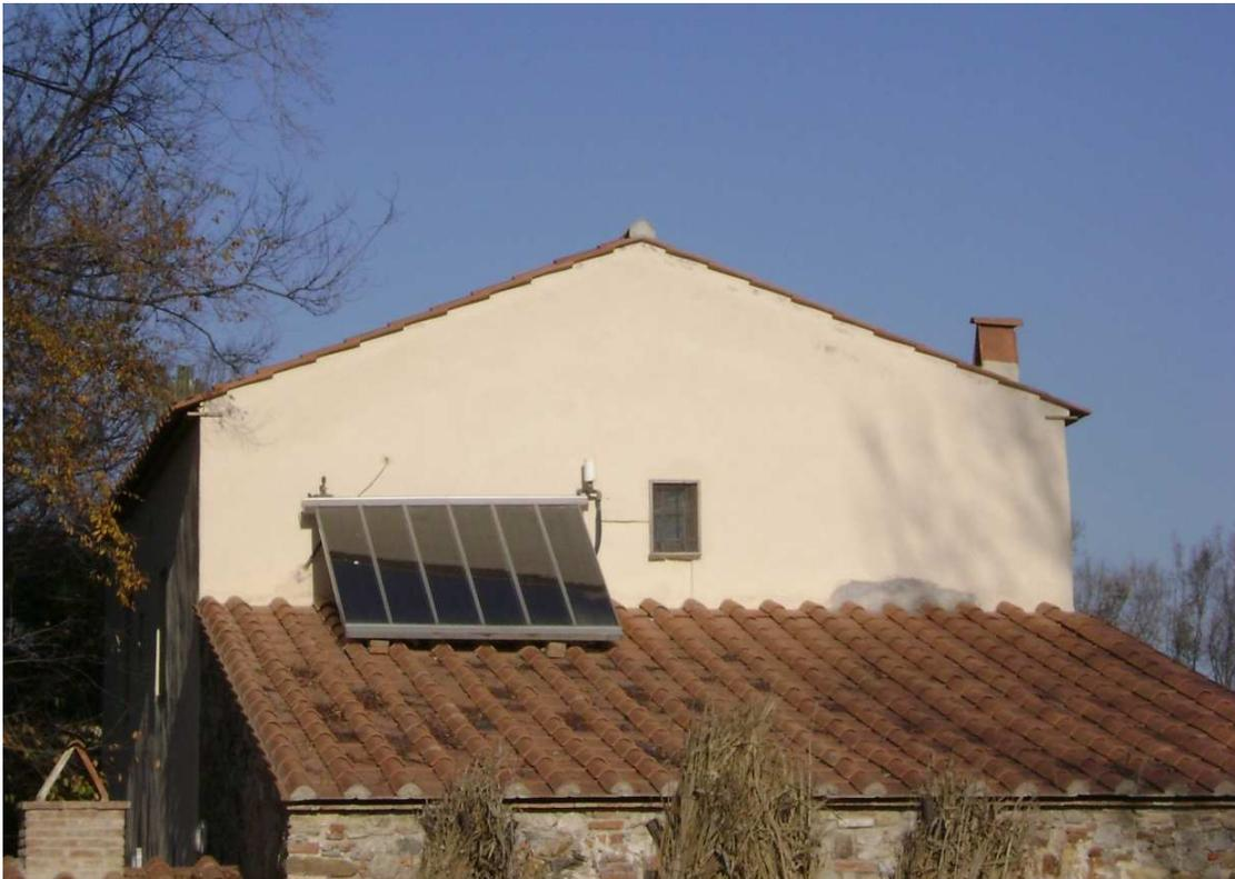
**Fotografia 9.4-1 : Fotografia del collettore solare piano sul tetto del casale C**
