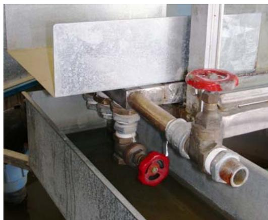
Figura 4.9 valvole di regolazione della pressione
