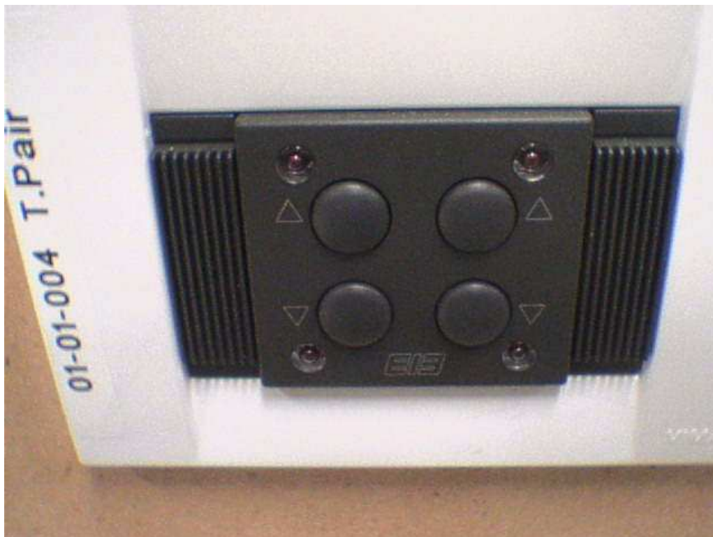
Figura 8.6: Pulsantiera Konnex a 4 canali.
