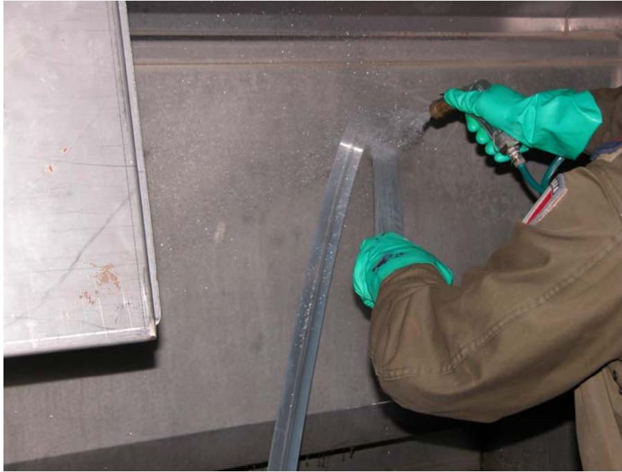
Figura 79. Lavaggio finale attraverso getto d'acqua corrente.
