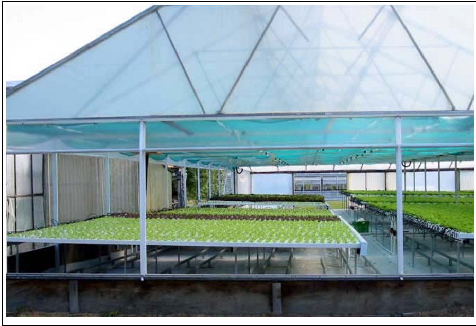
Coltivazione di lattuga in Floating System.
