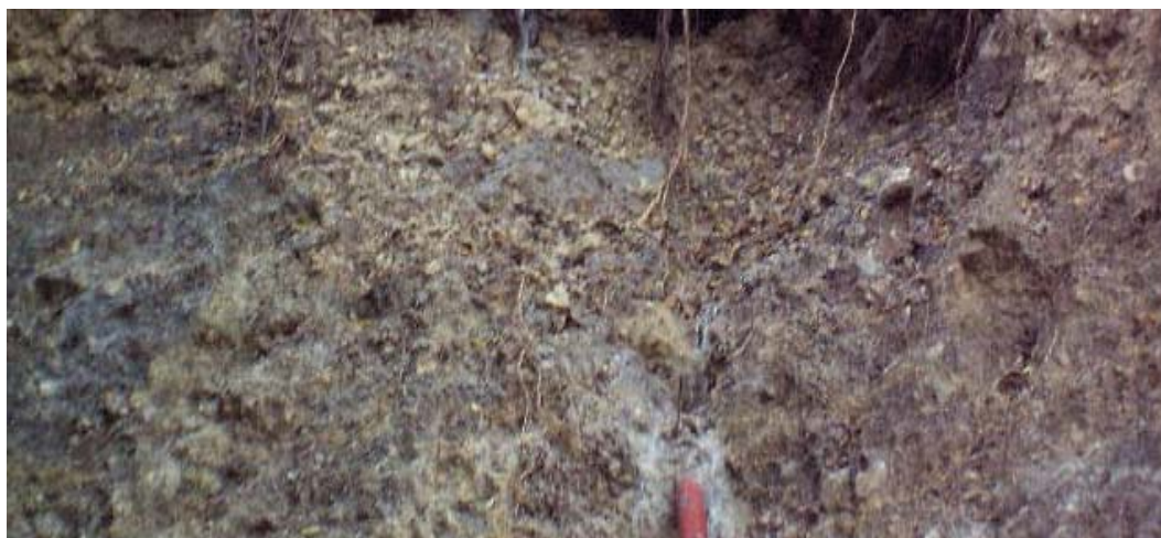
Figura 6- Porzione di corpo di frana.
