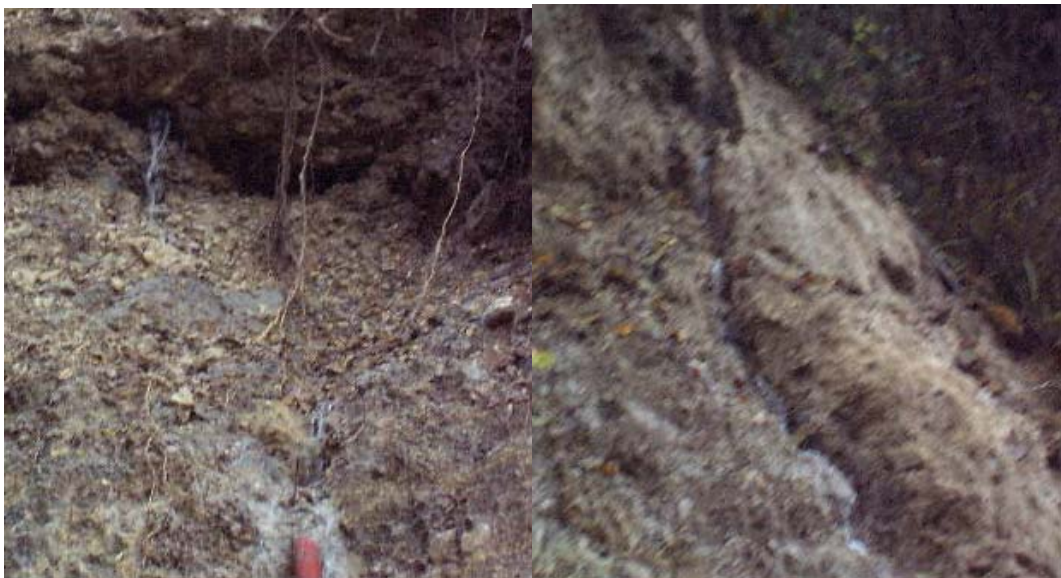
Figura 11-Evidenza di circolazione nella zona di distacco della frana illustrata nelle figure precedenti.
