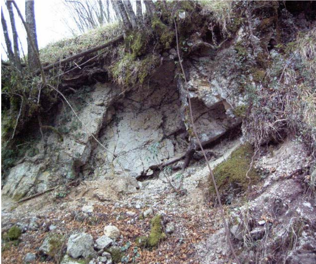
Figura 19-Crollo di maiolica nella zona a N di Trassilico.
