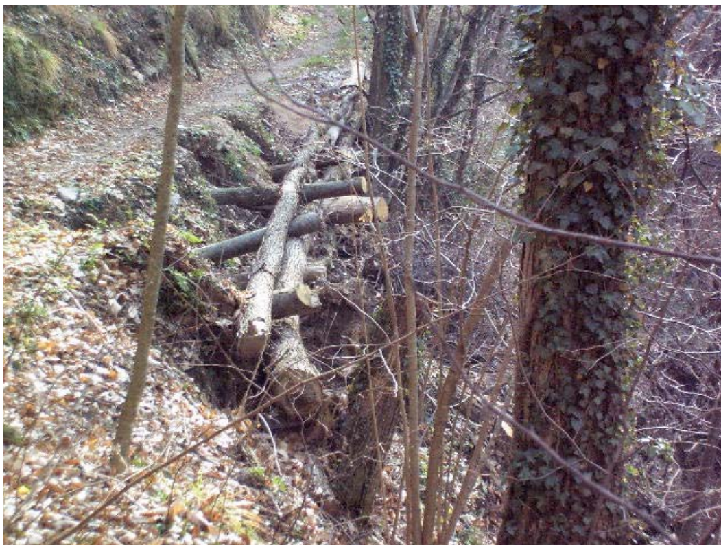
Figura 26- Piccola frana al margine di un sentiero nella zona di Case all'Aia. Il movimento è avvenuto in una zona dove era stato praticato un intervento di stabilizzazione. L'erosione continua nella parte posteriore della forma resa ormai particolarmente debole ed aggredibile.
