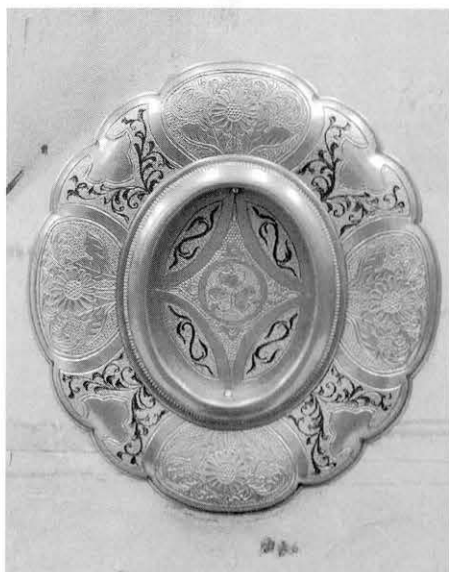
39 引き手金具の新調 Making new metal door fittings
