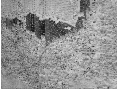
図26 図25中①硝酸ナトリウムの析出 (2013年9月18日)
