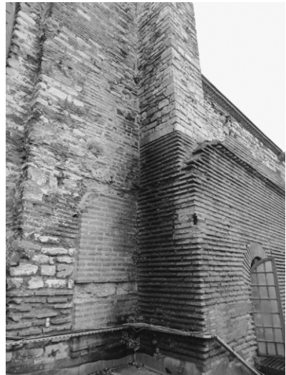
図21 2階北西部の外壁
