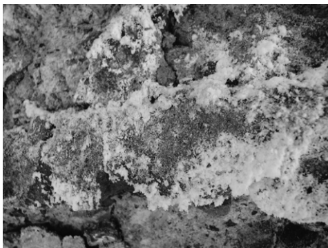
図17 図16中①硫酸ナトリウムの析出 (2013年10月9日)
