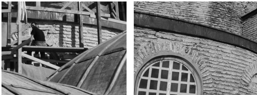
図2 漆喰除去作業の様子と除去後の状態（南西エクセドラ，左：2008年2月，右：2012年9月）
