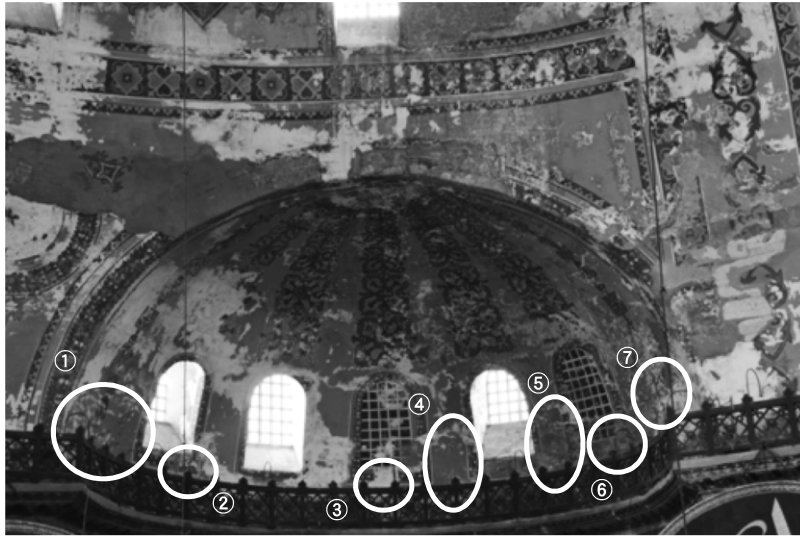
図10 北西エクセドラ内壁 析出塩サンプル採取場所
