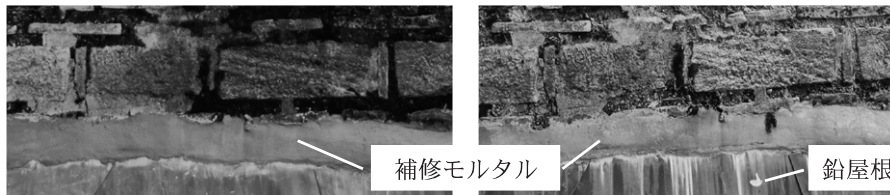
図7 北西エクセドラ外壁の補修モルタルの劣化による剝落（左：2011年2月，右：2012年8月）
