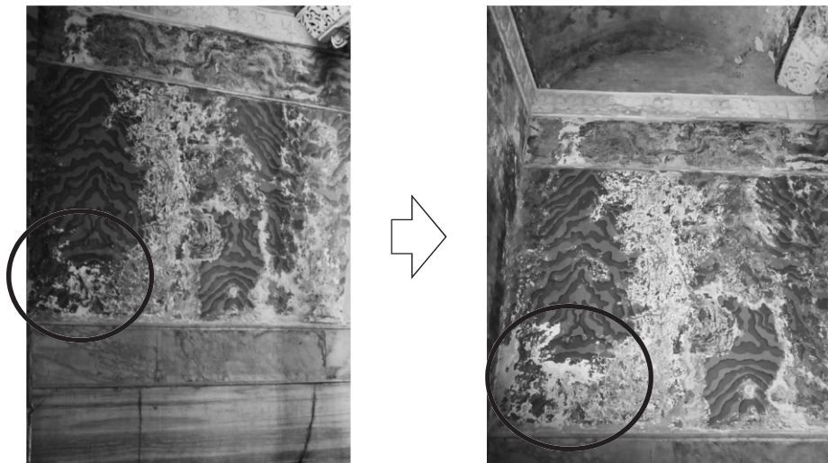
図3 ギャラリー階北西壁面における塩の析出状況（左：2006年11月，右：2010年9月）
