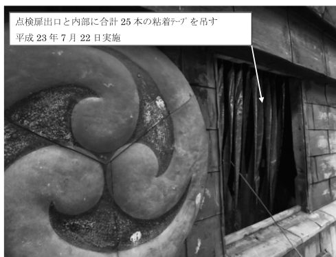
写真7 Mエリア（三仏堂屋根上、大棟南面の点検口（窓）をあけた出口）に設置した捕虫テープ 2011年7月22日に設置。
