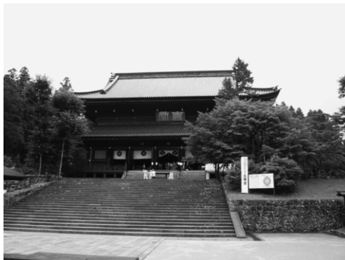
写真1 輪王寺三仏堂 1647年建立 (2008年7月撮影)
