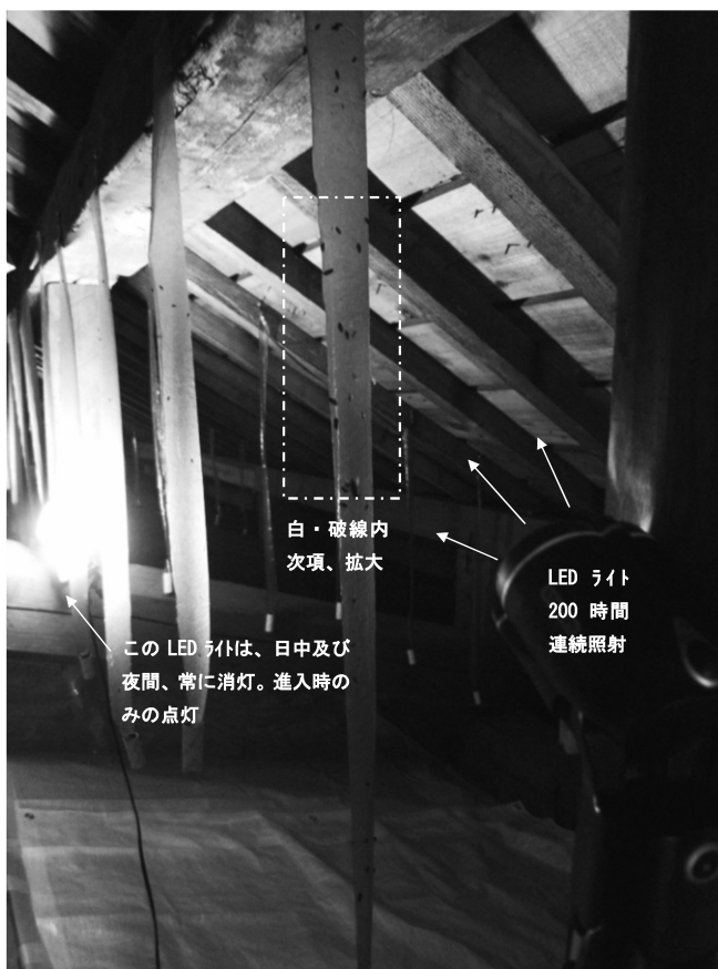
写真2 A 輪王寺本堂裳階（南）小屋内部（Aエリア）に設置されたLEDライト 2011年7月8日に粘着テープ設置，7月12日からLEDライトを設置（24時間連続照射）。 もっともライトから近い位置で光を照射したテープには，1週間で39頭のオオナガシバン ムシの付着が確認された。また，LEDライトから，遠ざかる程付着数は減少した。
