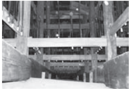
図19 輪王寺本堂（三仏堂）小屋裏
