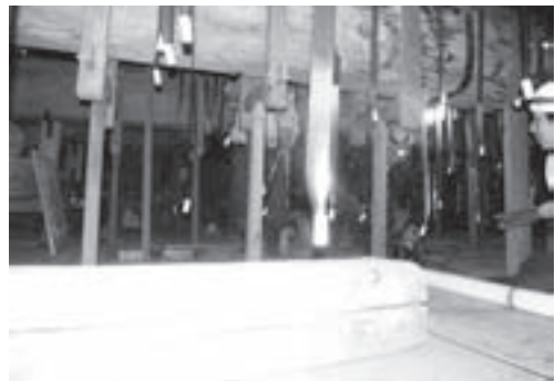
図23 経蔵（輪蔵）小屋裏
