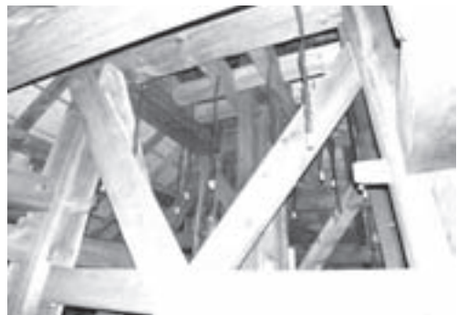
図21 中禅寺立木観音堂小屋裏
