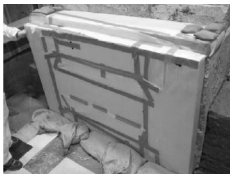
写真1 石室開口部を断熱材で覆った様子
