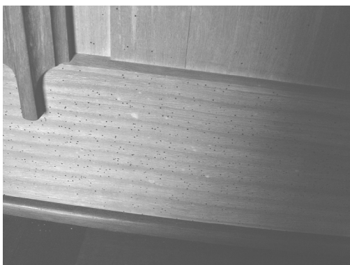
写真1 社交室の桐材の虫孔
