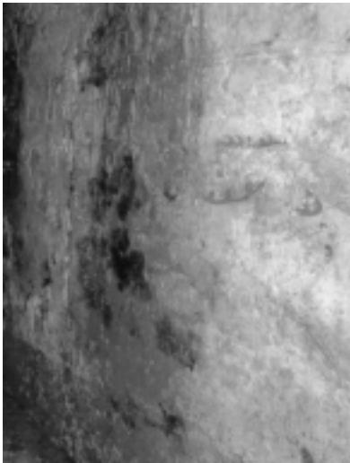
図12. 2002年10月28-30日の点検時に東壁の青龍付近にみられた黒色の汚れ
