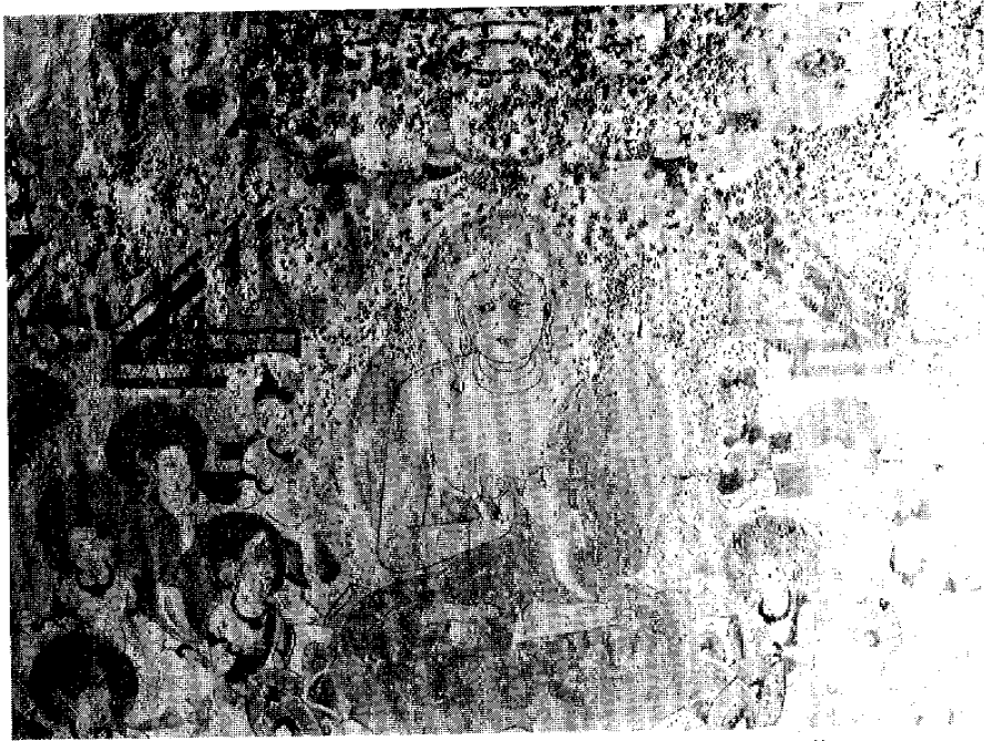
図2 194窟における塩類の晶出と壁画の剥落 壁画上部ほど塩類晶出が密で、粒が大きい
