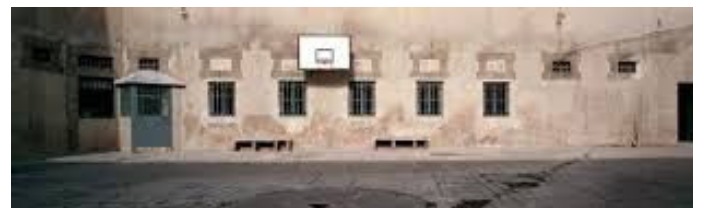
Rehabilitación de la Cárcel. La Fábrica. Segovia.
