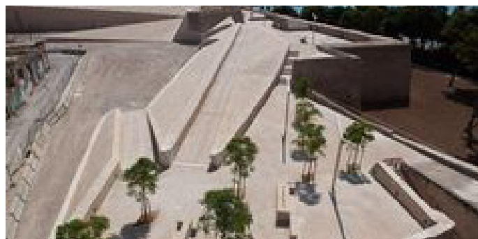
Intervención en las murallas. Lapeña y Torres. Palma de Mallorca.
