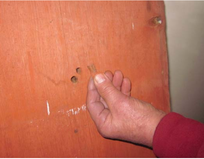
Kuva 27. Puutapilla kiinnitetty ulkovuorilauta Isojoelta. Kuva Matti Mäkelä.
