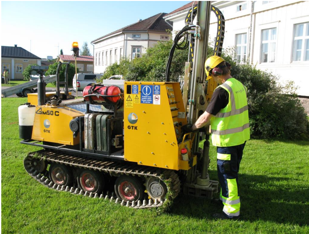
Kuva 35. Maakairausta Raahessa GTK:n GM50-kairakalustolla. Satu Hietala, GTK.
